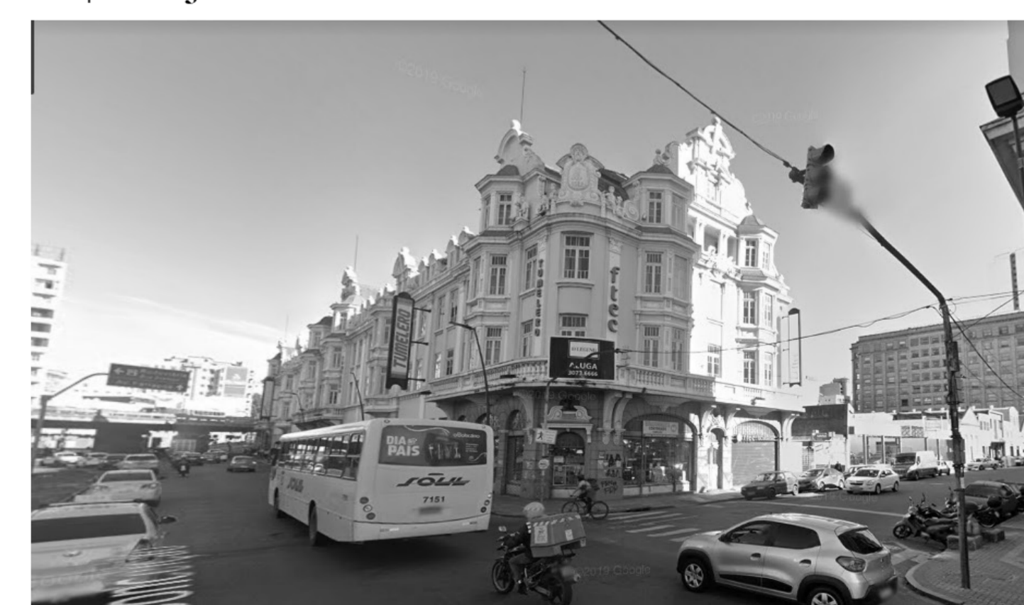
07 | Edifício Ely a partir da Rua da Conceição
