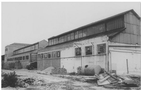
Fábrica, onde hoje funciona o Sesc Pompéia, abandonada em 1972. Foto: Paquito/Divulgação
