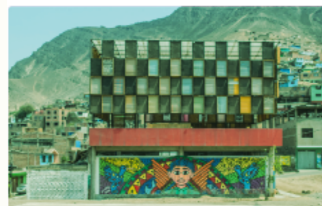
espaço comunitário do refeitório san martín
