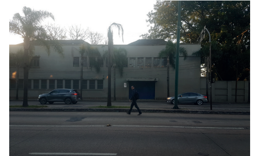
Vista de uma acesso do terreno Av Farrapos
