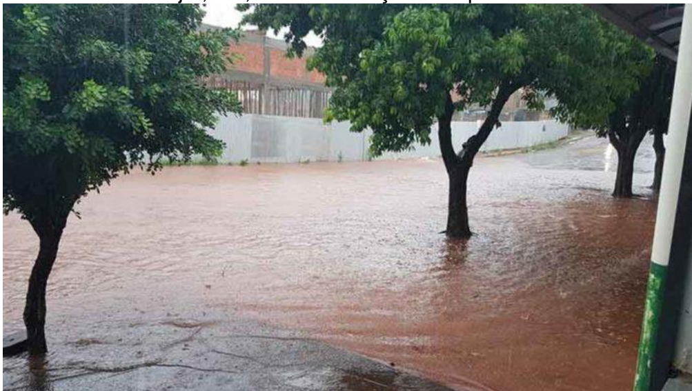
Figura 65: Área inundada em pavimento sobre a canalização do Arroio do Moinho no Centro de Ijuí, RS, Unidade Praça da República.
