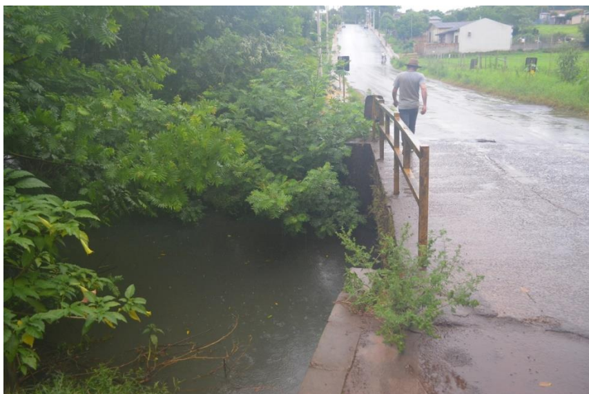
Unidade Jardim Primavera. Fotografia: Trabalho de Campo. Data: 15/01/2020. Coordenadas Geográficas: S28°37'45.44", W53°35'56.93".
