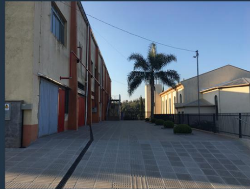
acesso secundário (saída de emergência)
