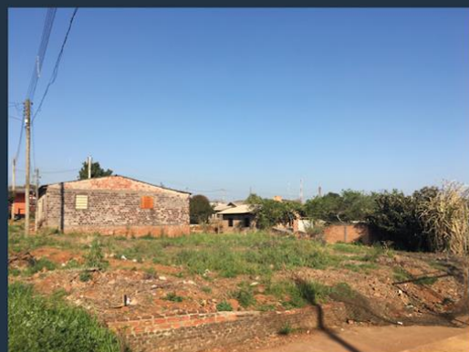
terreno entra quadra e edificação inutilizado
