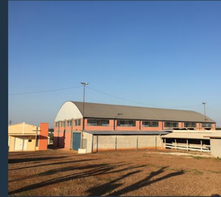
visão geral do equipamento
