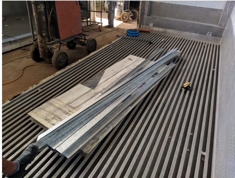
FIGURA 22 - CALHAS DE METAL
