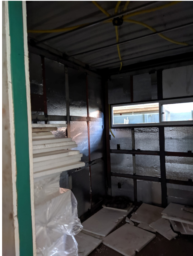
FIGURA 14 - POSICIONAMENTO DE ELETRODUTOS
