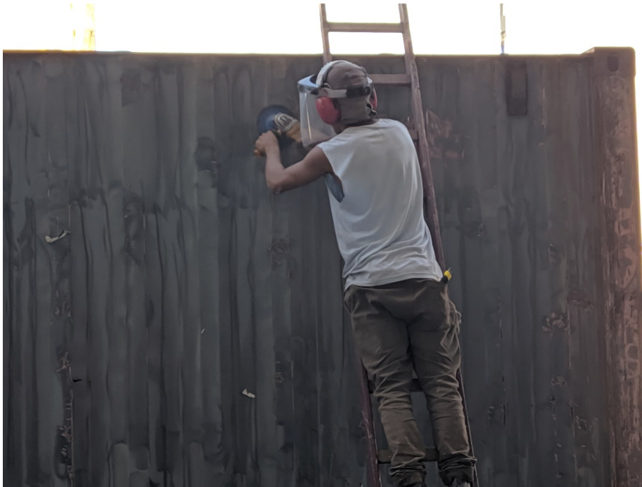
FIGURA 10 - LIXAMENTO PARA REGULARIZAÇÃO DA SUPERFÍCIE
