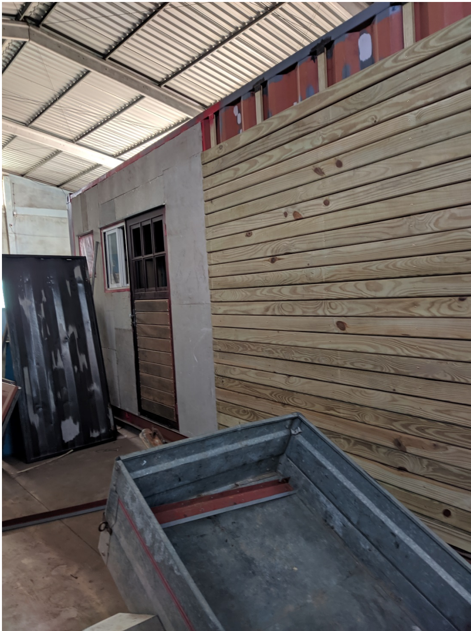
FIGURA 12 - CONTÊINER COM REVESTIMENTO EXTERNO EM MADEIRA
