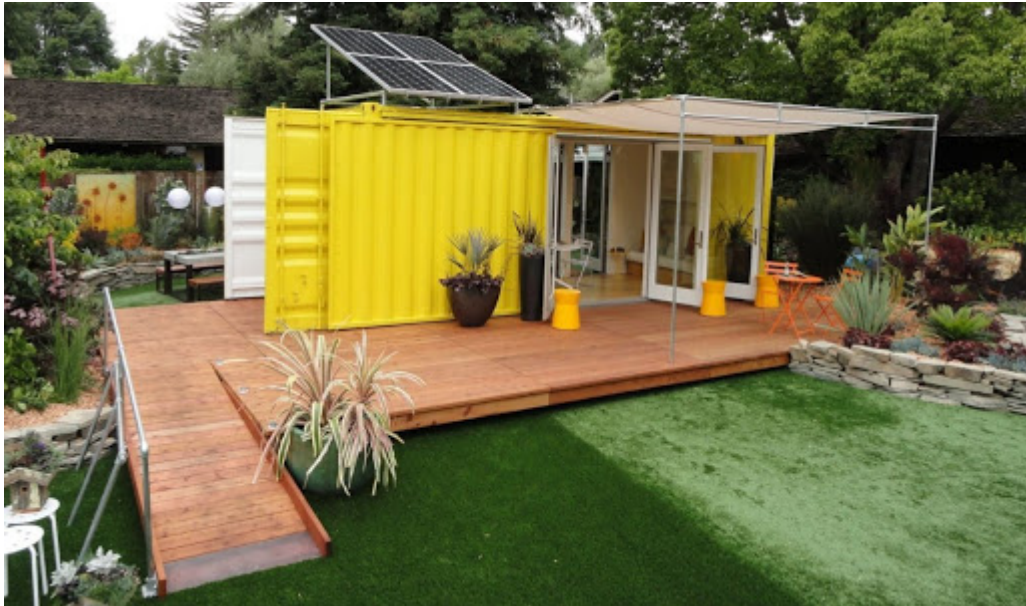
FIGURA 23 - CASA-CONTÊINER COM TETO SOLAR
