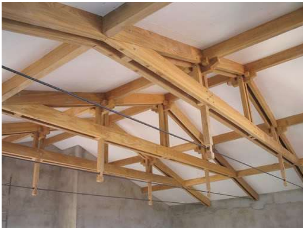
Figura 29 – Tesoura com peças solidarizadas descontinuamente
