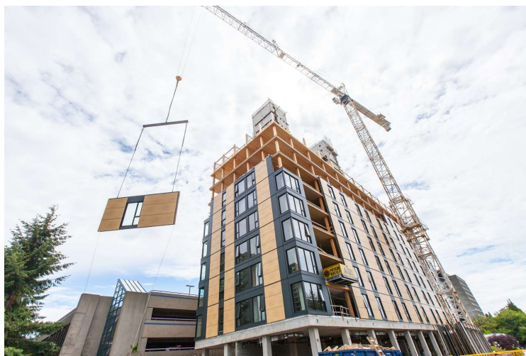
Figura 11 – Brock Commons Tallwood House 11 , Canadá
