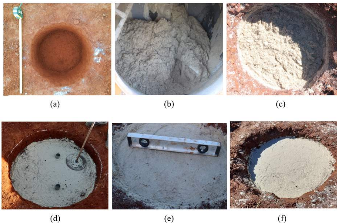
Figura 4.19 – Etapas de moldagem a) abertura da cava; b) mistura na betoneira; c) preenchimento camada; d) cilindro cortante para verificação do peso específico; e) verificação do nível; f) camada finalizada.
