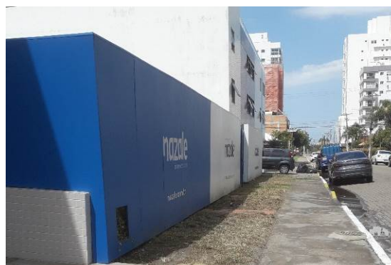
Figura 8.27: Obra na quadra 3B1
