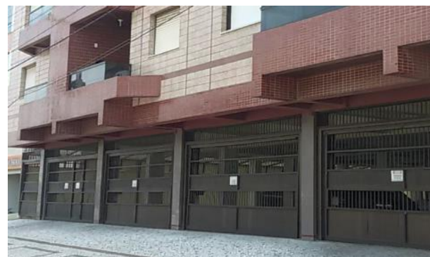
Figura 3.30: Edifício com pilotis no térreo em Capão da Canoa - RS Fonte: Autora (2019)
