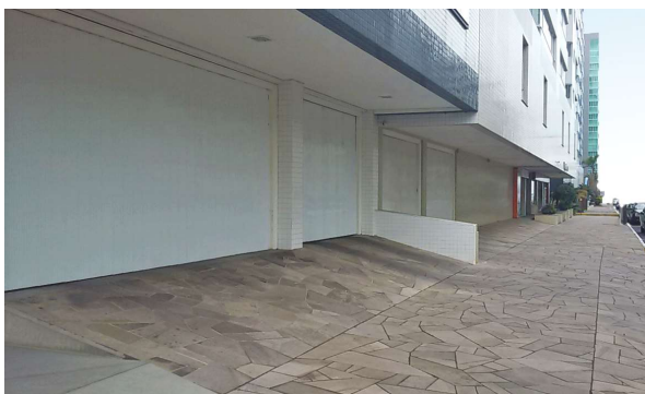
Figura 5.47: Cena com portas de garagem e paredes cegas nos térreos
