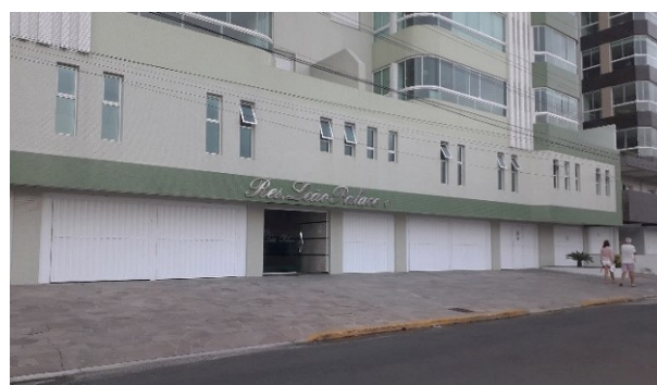
Figura 4.8: Baixa conexão física entre os pavimentos térreos e a rua - Capão da Canoa Fonte: Autora (2019)
