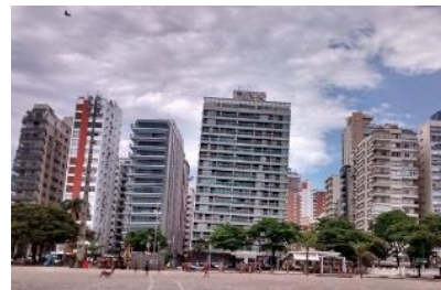
Figura 2.15: Prédios inclinados na orla de Santos
