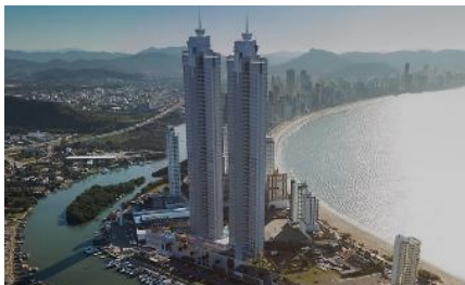
Figura 2.13: Edifício Yachthouse Residence Club em construção em Balneário Camboriú
