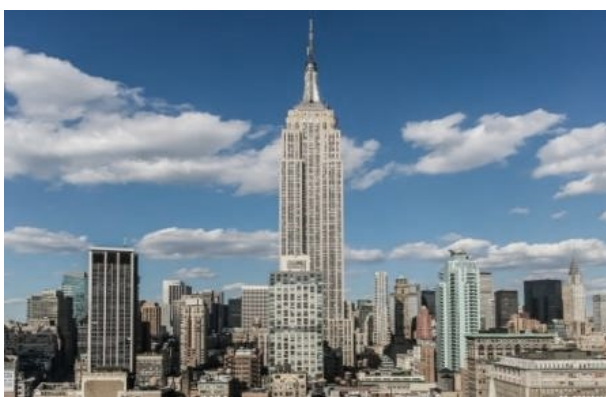
Figura 2.5: Empire State Building (102 pavimentos e 381 metros de altura) em Nova Iorque
