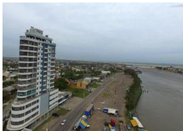
Figura 2.14: Edifício de 15 andares que está sendo construído na cidade de Imbé
