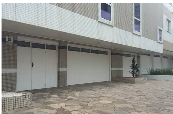
Figura 8.26: Portas de acesso a garagens nos térreos das edificações na quadra 3A2
