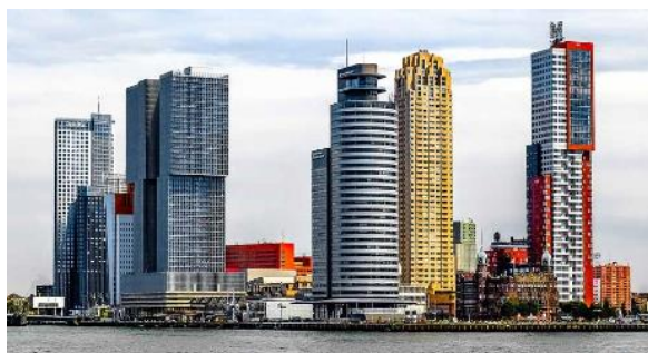
Figura 3.2: Arranha-céus em Roterdã, Holanda Fonte: https://rotterdamstyle.com/listicles/the-10-tallest-buildings-in-rotterdam
