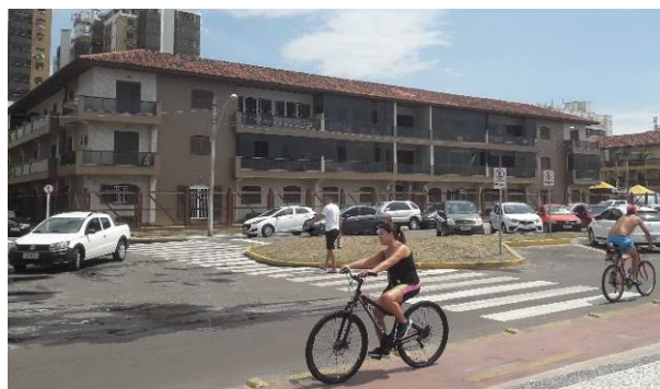
Figura 6.4: Edifício Aymoré, primeiro a ser construído na beira da praia de Capão da Canoa durante a década de 1940
