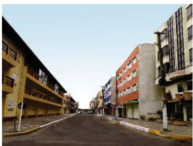
Figura 5.45: Cena de via coletora com edifícios baixos Fonte: Autora (2018)
