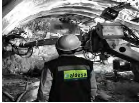
Figura 4-1-3. Túnel en la Supervía poniente en estado de México
