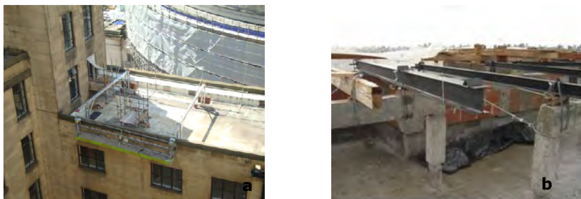
Figura 3-3-4. (a) Sistema modular para sustentar andamios suspendidos; (b) Vigas de hormigón armado especialmente proyectadas para el apoyo de perfiles que sujetan el andamio
