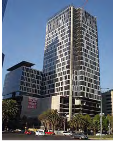
Figura 4-1-4. Edificio corporativo de Mapfre en Distrito Federal
