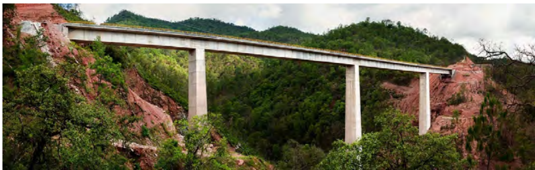
Figura 4-1-1. Puente Pueblo Nuevo, Autopista Durango-Mazatlán
