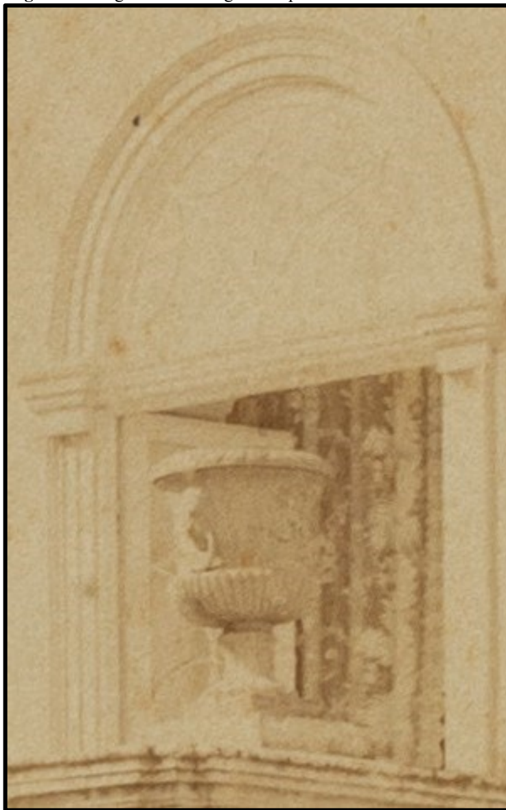
Imagem 39: Fragmento da Imagem 36: porta de entrada da casa dos Ely
