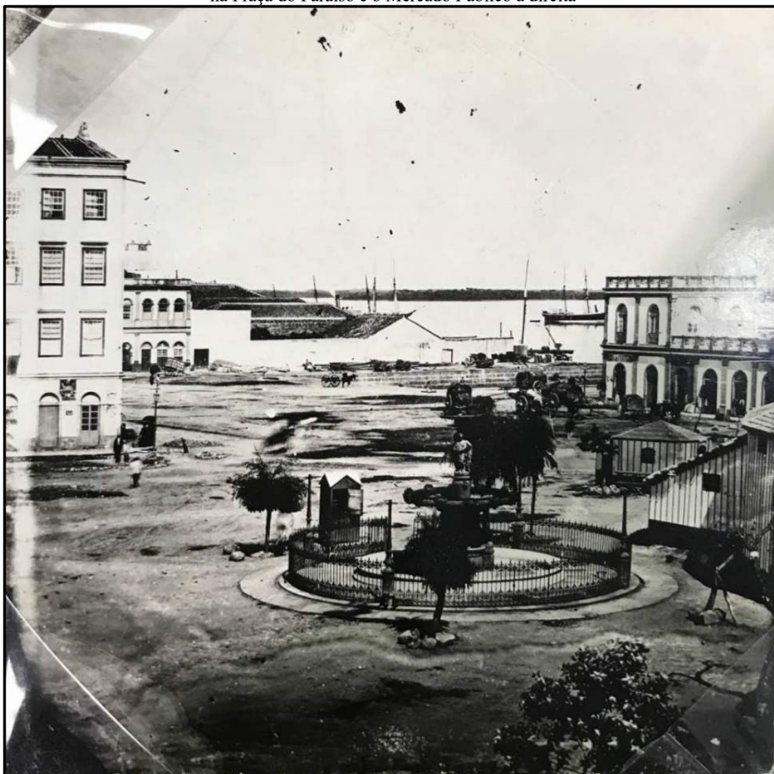
Imagem 32: O Edifício Malakoff, à esquerda, o chafariz da Hidráulica Porto-Alegrense ao centro, na Praça do Paraíso e o Mercado Público à direita
