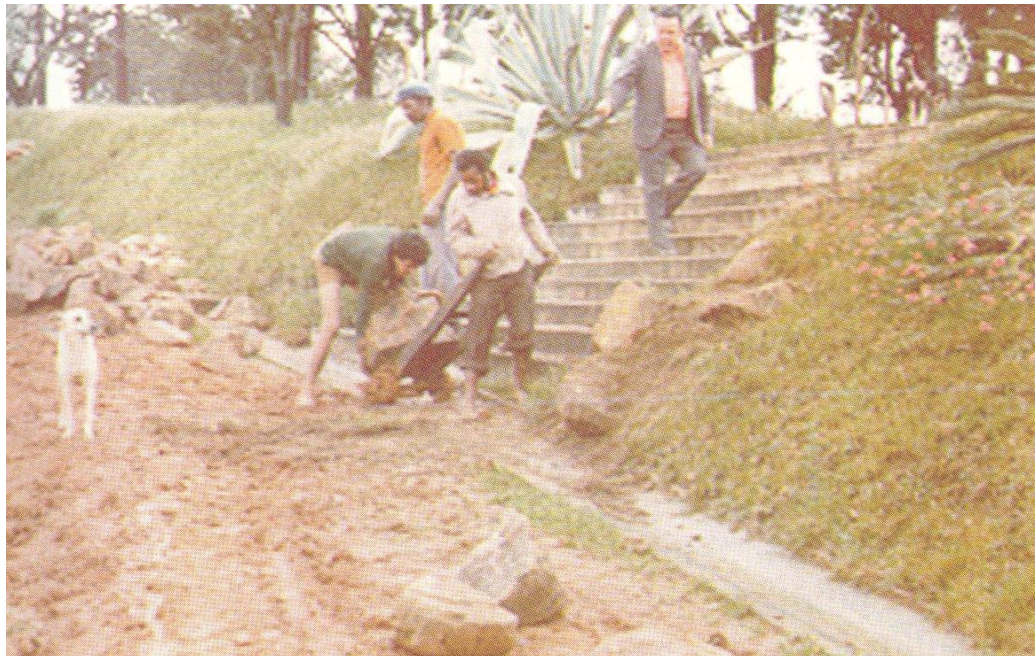
Figura 9: Construção do acesso principal do Jardim Botânico.
