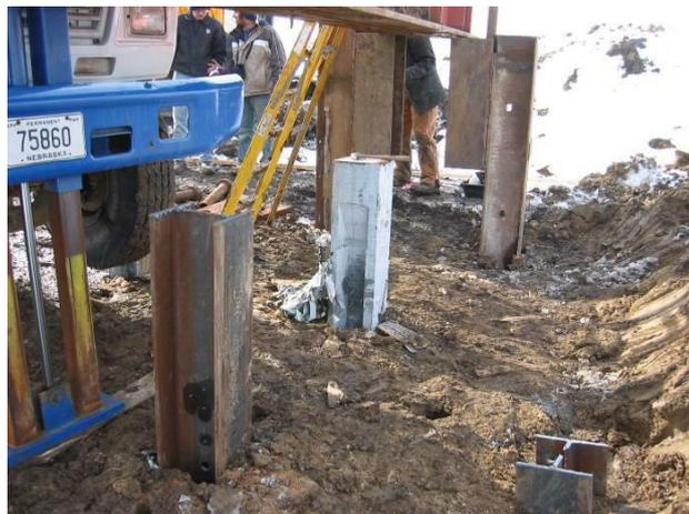
Figura 2.12 - Exemplo de estacas ensaios experimentais com estacas de CUADRF. Fonte: Iowa State University apud FHWA (2019).
