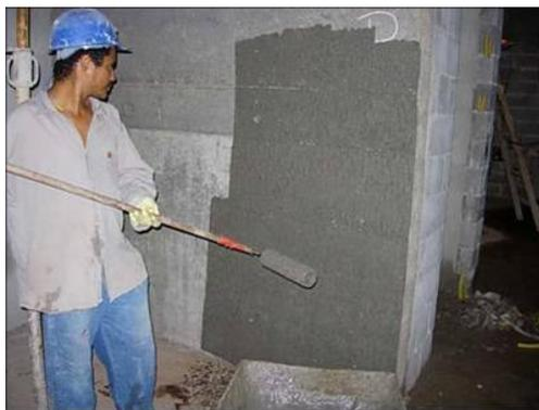
Figura 3: aplicação de chapisco rolado (MACEDO et al., 2007)
