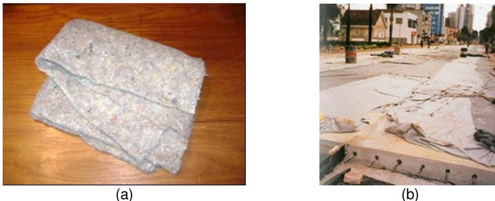
Figura 24: (a) manta para cura utilizada no experimento e (b) exemplo do uso em obra (fonte: [www.geobrasil.com.br](http://www.geobrasil.com.br))
