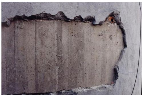
Figura 9: deslocamento de revestimento de argamassa aplicado sobre substrato de concreto estrutural (CARASEK et al., 2005)
