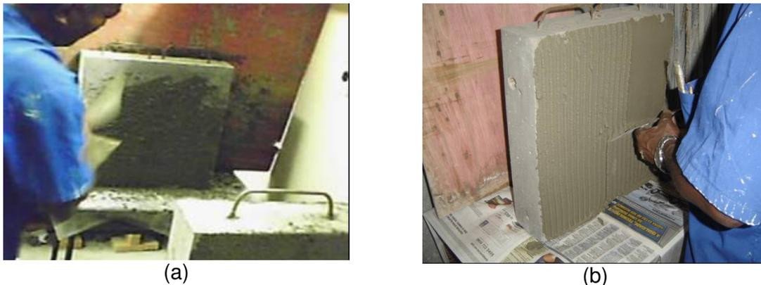
Figura 35: (a) aplicação de chapisco convencional e (b) industrializado
