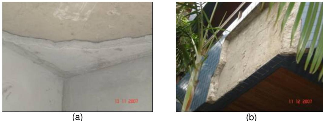
Figura 10: deslocamento de revestimento interno e externo de argamassa aplicado sobre substrato de concreto estrutural: (a) fundo de laje e (b) viga
