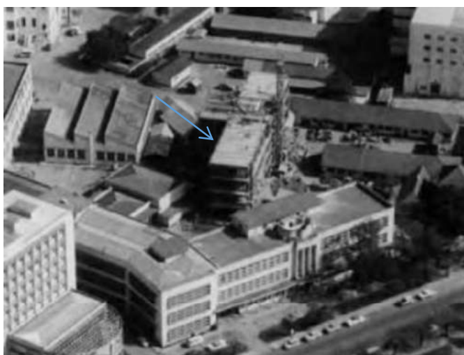
Figura 16 – Prédio do CAP sendo construído
