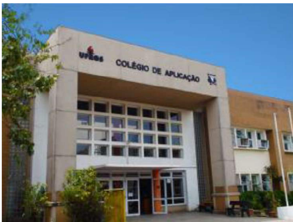
Figura 57 - Prédio Sede do CAp no Campus do Vale da UFRGS
