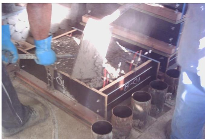
**Figura 17 - Lançamento e adensamento do concreto nas fôrmas**
