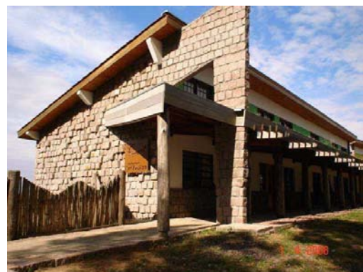
Figura 10: Fachada Leste (Bloco 1) da Escola Frei Pacífico
