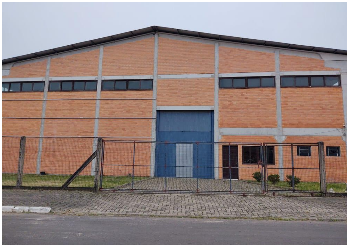
Figura 2. Lado externo do pavilhão destinado ao Parque Tecnológico de Osório.
