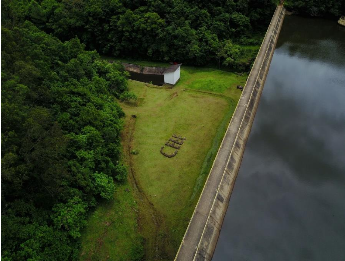
Figura 19: Vista Aérea da Barragem da UHE Canastra
