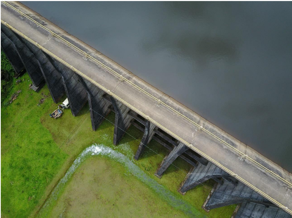
Figura 14: Vista Aérea da Barragem da UHE Canastra.
