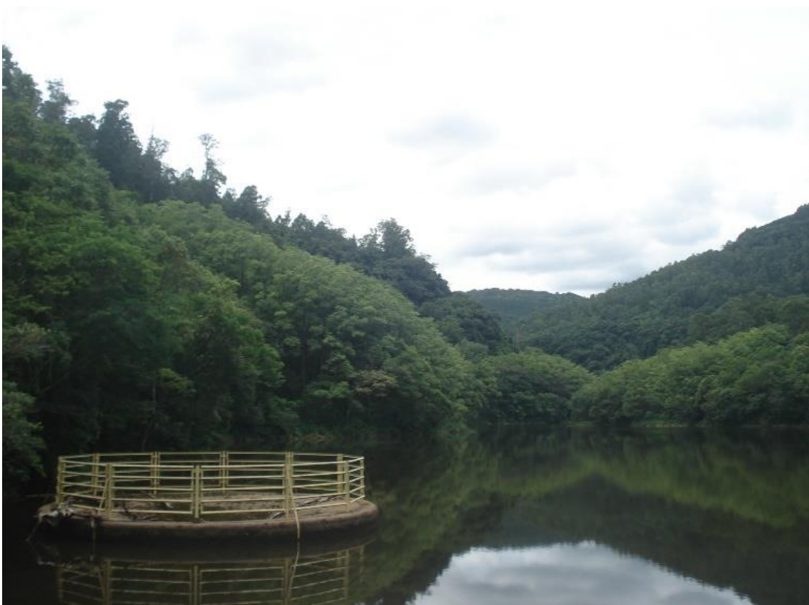
Figura 16: Vertedouro do tipo Tulipa.
