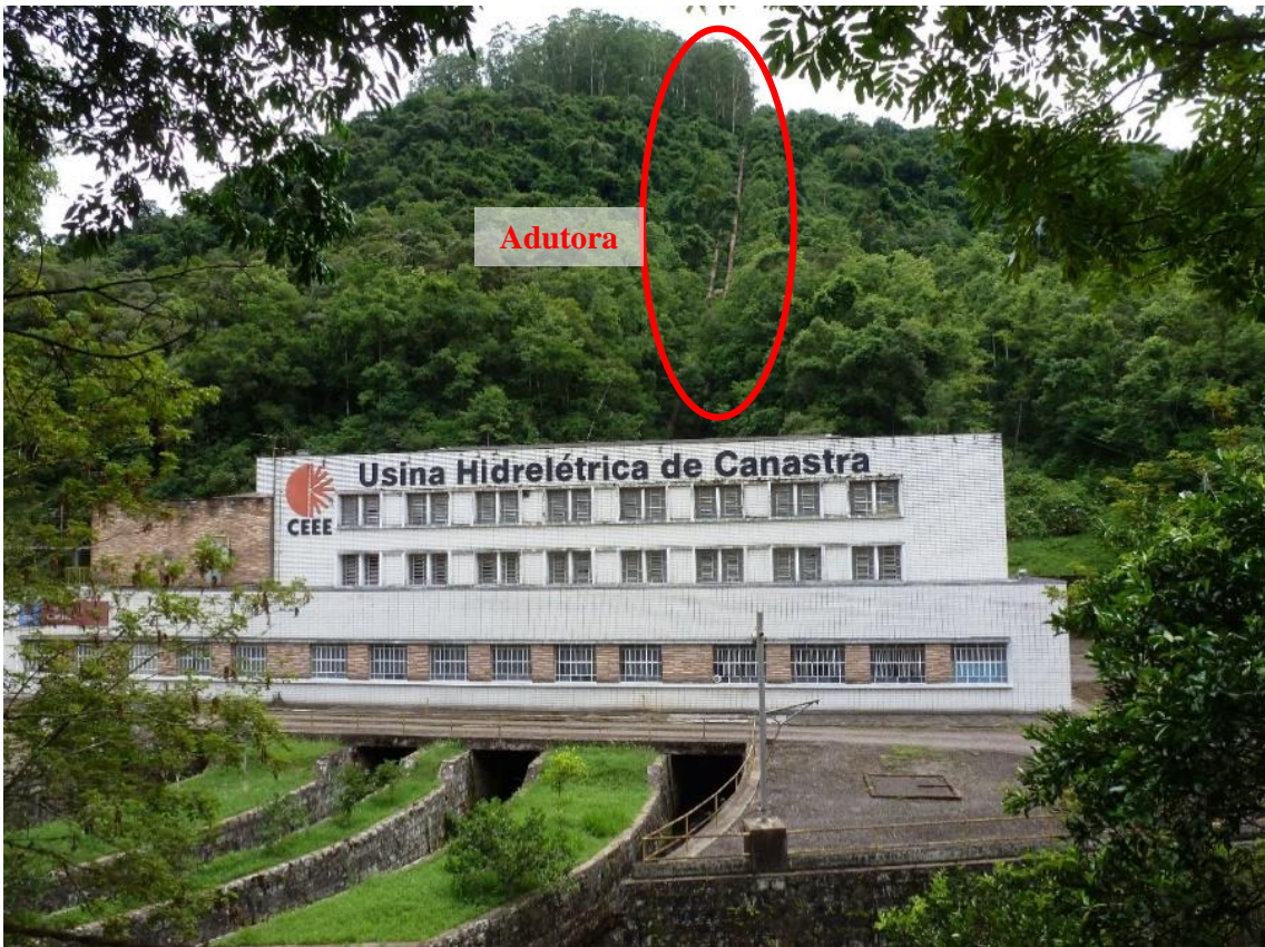
Figura 20: Usina Hidroelétrica de Canastra e adutora.
