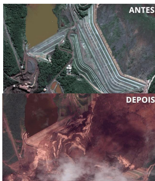
Figura 9: Antes e depois do rompimento da barragem de Feijão, Brumadinho (G1, 2019).
