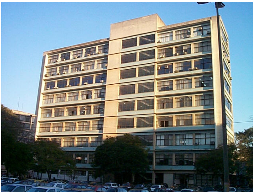
Figura 1 – Prédio da Faced, “Torre Azul” Acervo: Museu da UFRGS
