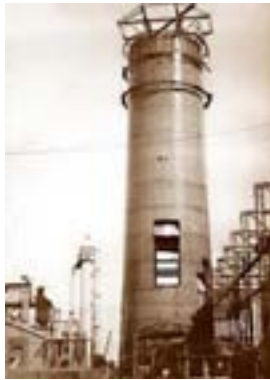
Figura 1 - Construção da Chaminé da Usina do Gasômetro
