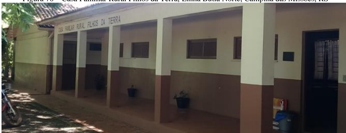
Figura 70 – Casa Familiar Rural Filhos da Terra, Linha Butiá Norte, Campina das Missões, RS
