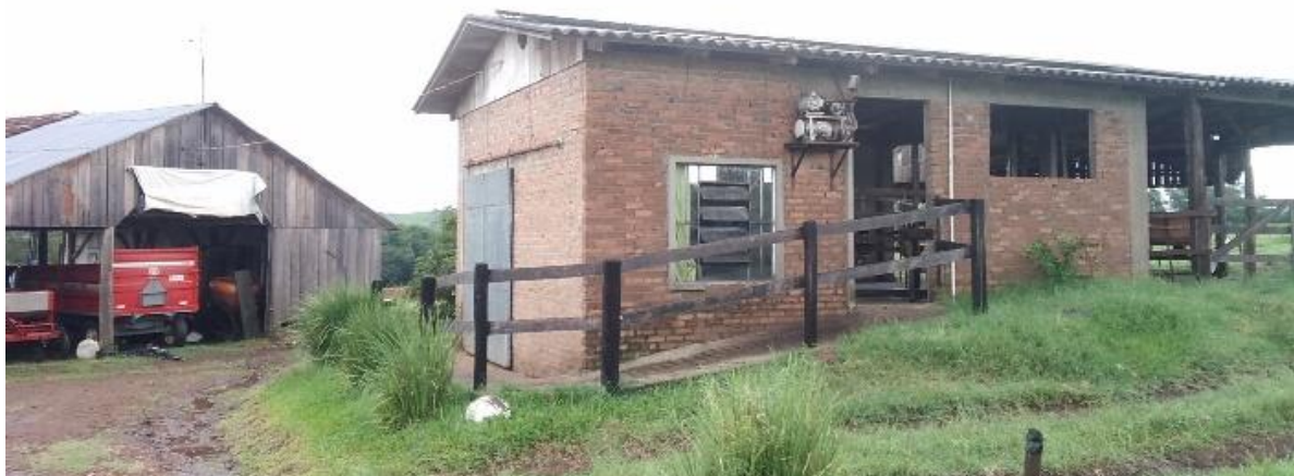
Figura 29 - Sala de ordenha e, ao fundo, galpão de máquinas em UPA “Tipo Leite”, Linha Rolador Baixo, Santo Cristo
