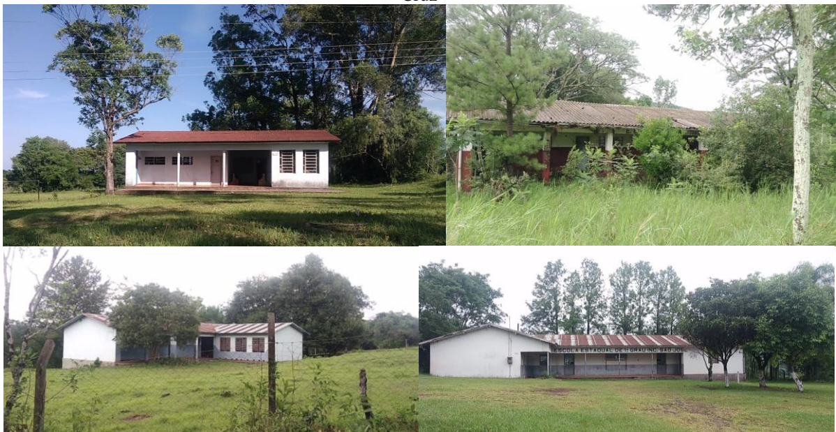
Figura 16 - Estruturas de escolas estaduais abandonadas na zona rural dos municípios de Alecrim e Porto Vera Cruz
