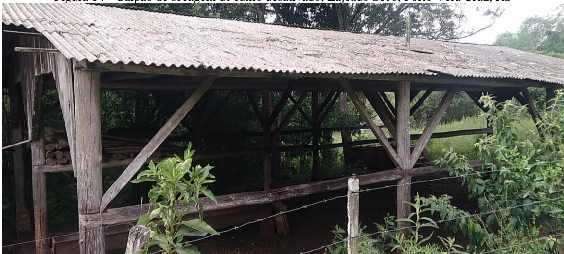
Figura 14 - Galpão de secagem de fumo desativado, Lajeado Seco, Porto Vera Cruz, RS
