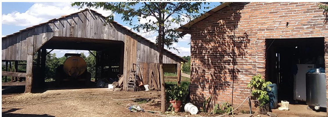
Figura 44 - Galpão de alimentação do gado bovino e sala de ordenha e em UPA “Tipo Leite+Suínos”, São Miguel, Nova Candelária
