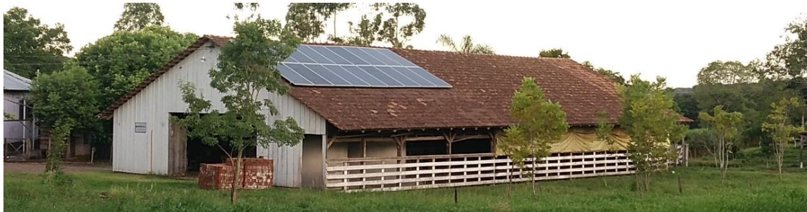
Figura 74 - Galpão com placas fotovoltaicas instaladas a partir de recursos do Pronaf Eco, Linha Taquaruçu, Santo Cristo
