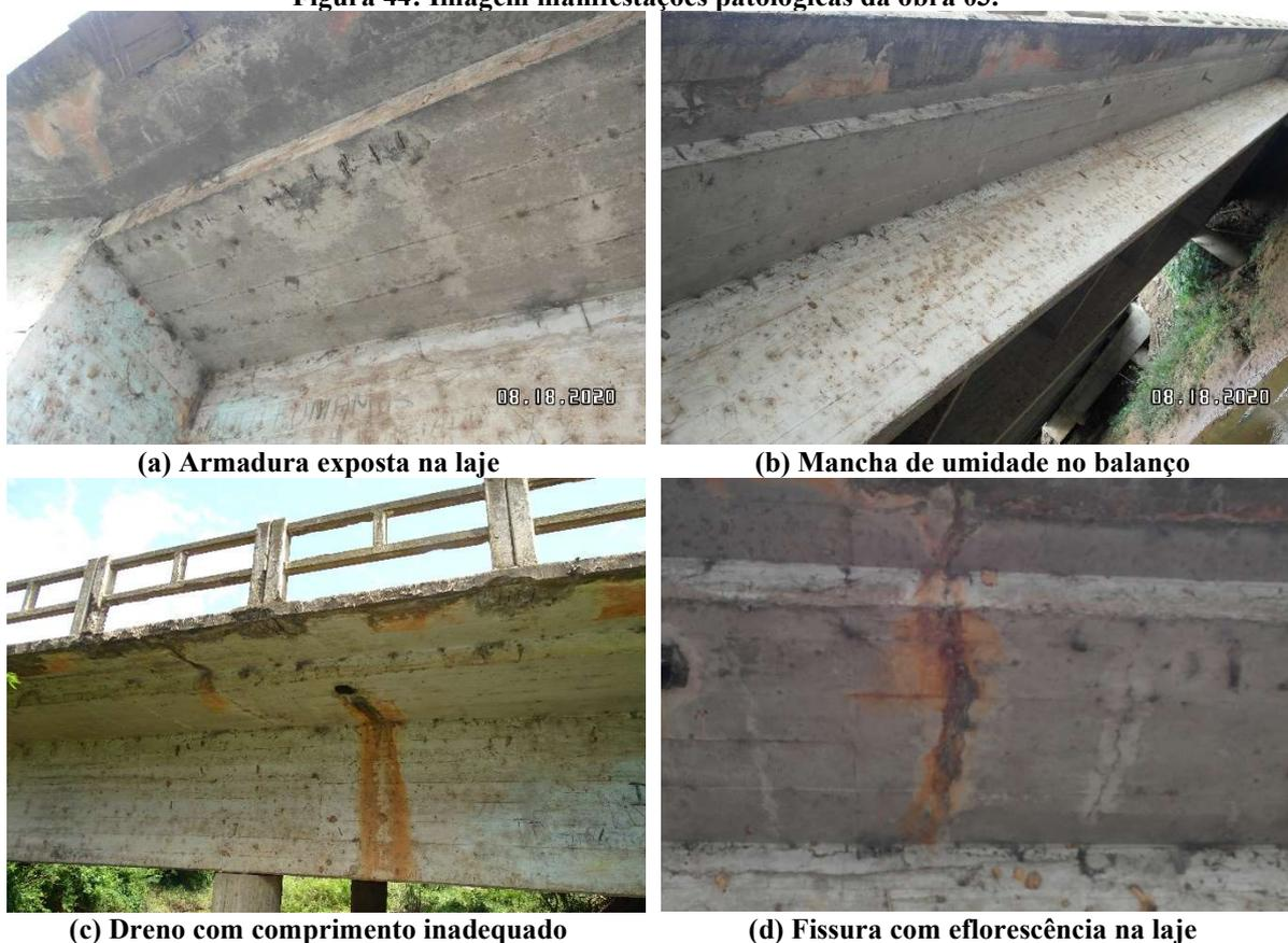
Após a análise dos resultados do ensaio de carbonatação, a nota de durabilidade sofreu a mesma alteração ocorrida na OAE 01. Durante a realização dos ensaios foi detectada armadura em processo evolutivo de corrosão no lado externo da viga direita no balanço.
