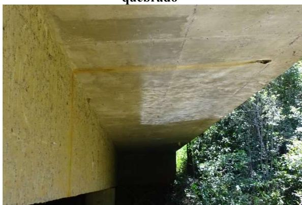
**(c) Dreno com comprimento inadequado**
