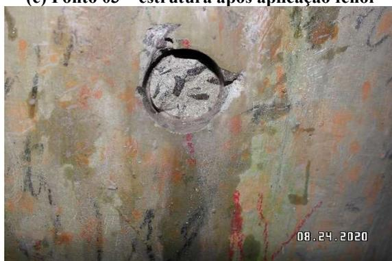
**(g) Ponto 04 – estrutura após aplicação fenol**
