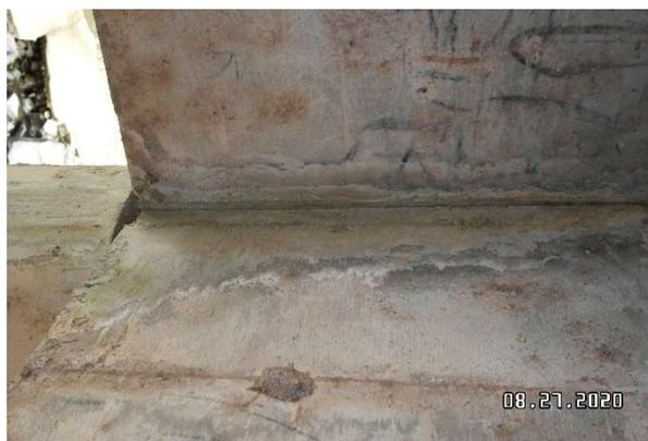
**(c) Mancha de umidade na viga lado interno**
