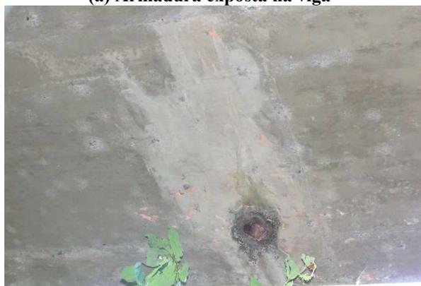
**(c) Dreno com comprimento inadequado**
