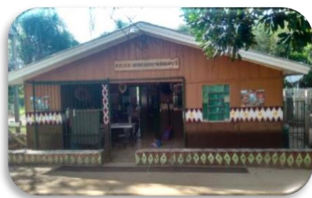
Foto 4: Fachada da Escola
