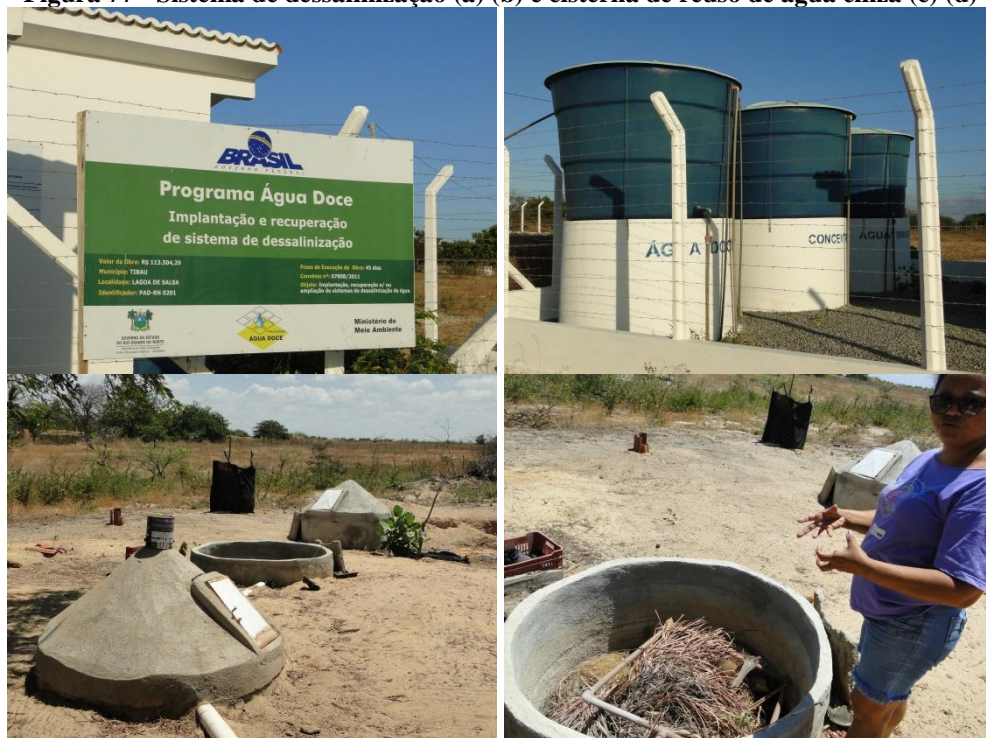
Figura 77 - Sistema de dessalinização (a) (b) e cisterna de reuso de água cinza (c) (d)
