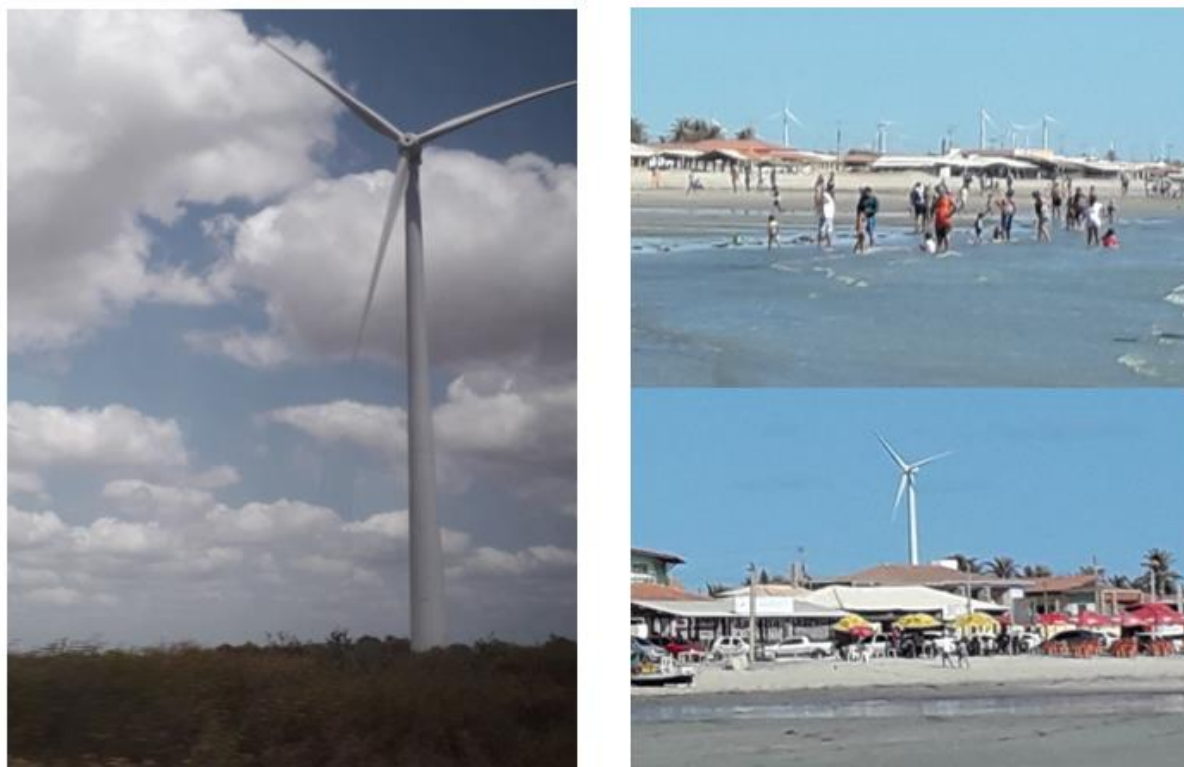
Figura 61 - Aerogeradores de energia eólica (Tibau)
