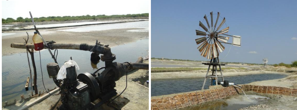
Figura 11 - Bomba a motor (a) e cata-vento (b) nas Salinas do Córrego (Grossos)
