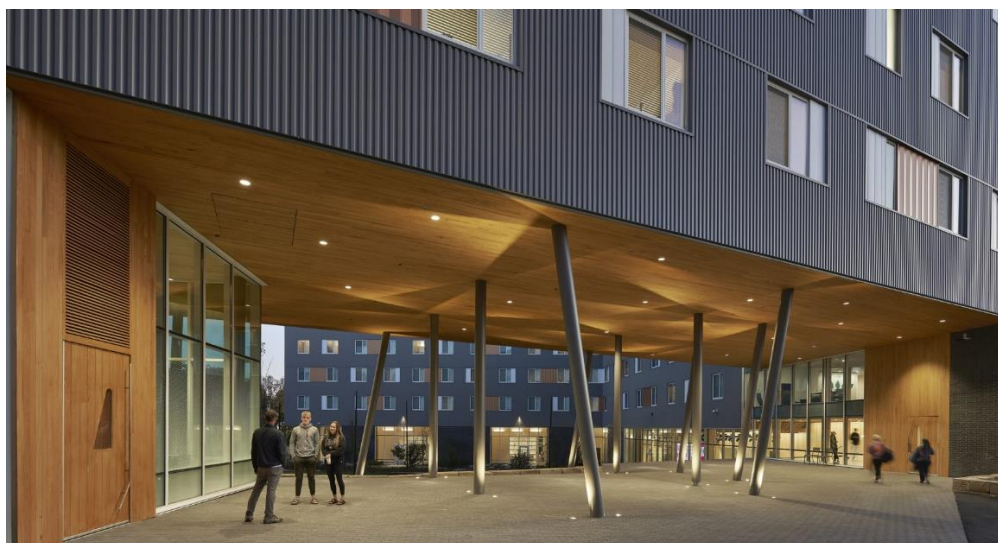
Figura 6 – Laje CLT apoiada sobre colunas, na Universidade de Arkansas, EUA. Retirado de < www.wooddesignandbuilding.com > Acesso em 05/02/2020
