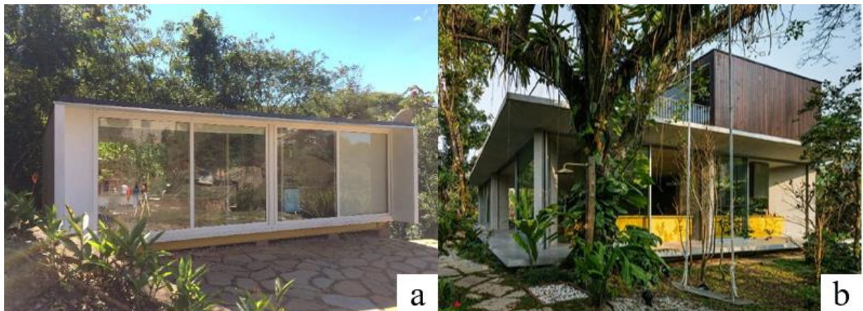
Figura 3 – Construções no Brasil de um (a) e dois (b) pavimentos executados empregando o CLT. (OLIVEIRA, 2018)
