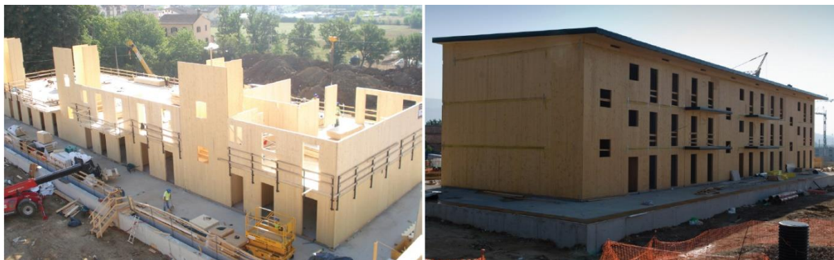
Figura 2 – Edifício de CLT na Itália. (KARACABEYLI e GAGNON, 2019)
