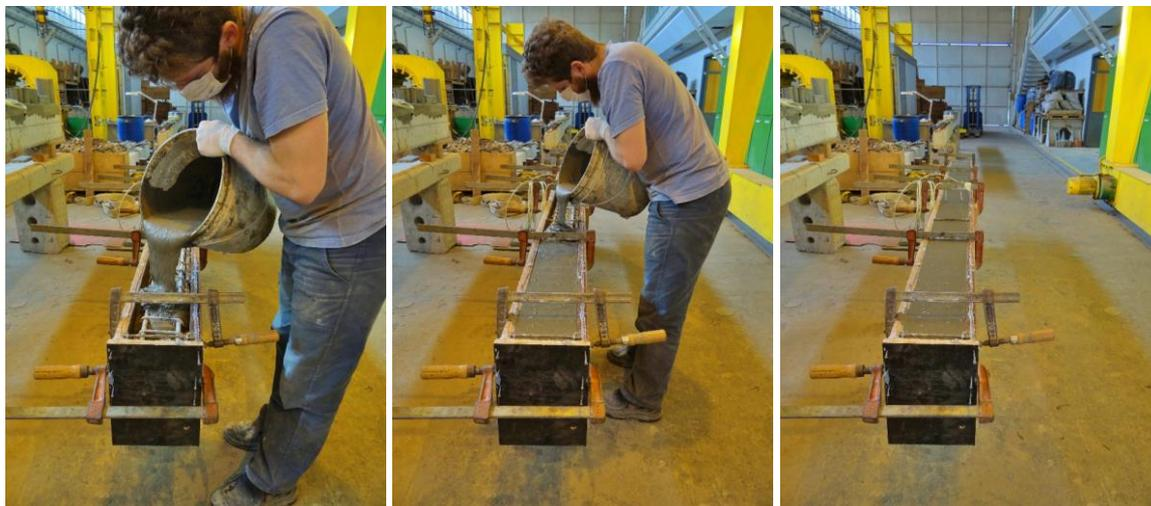
Figura 37: Sequência da recuperação com UHPFRC
