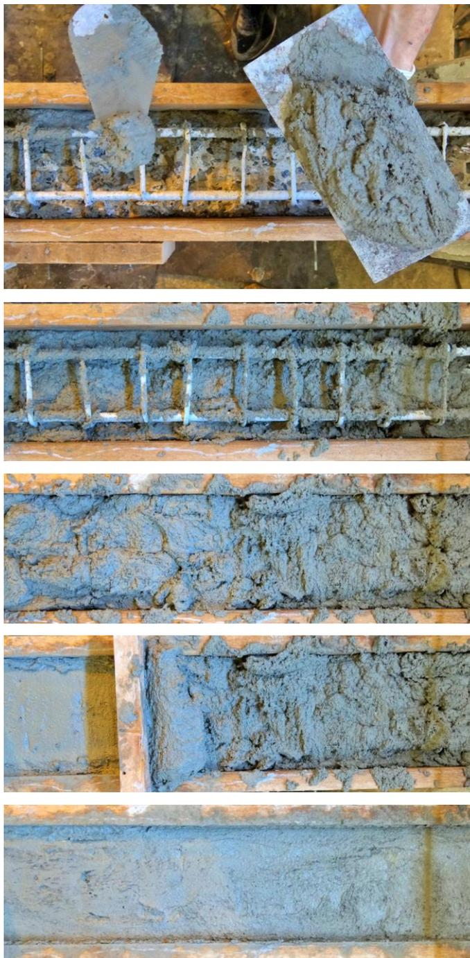
Figura 40: Sequência da recuperação com Concreto Têxtil
