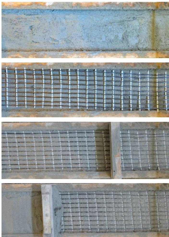
Figura 41: Sequência de posicionamento das camadas da malha têxtil
