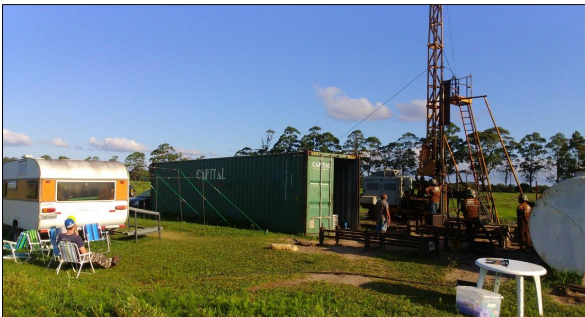
Figura 8: Execução do poço de exploração CBM002-ST-RS, na cidade de Osório/RS, novembro de 2019.
