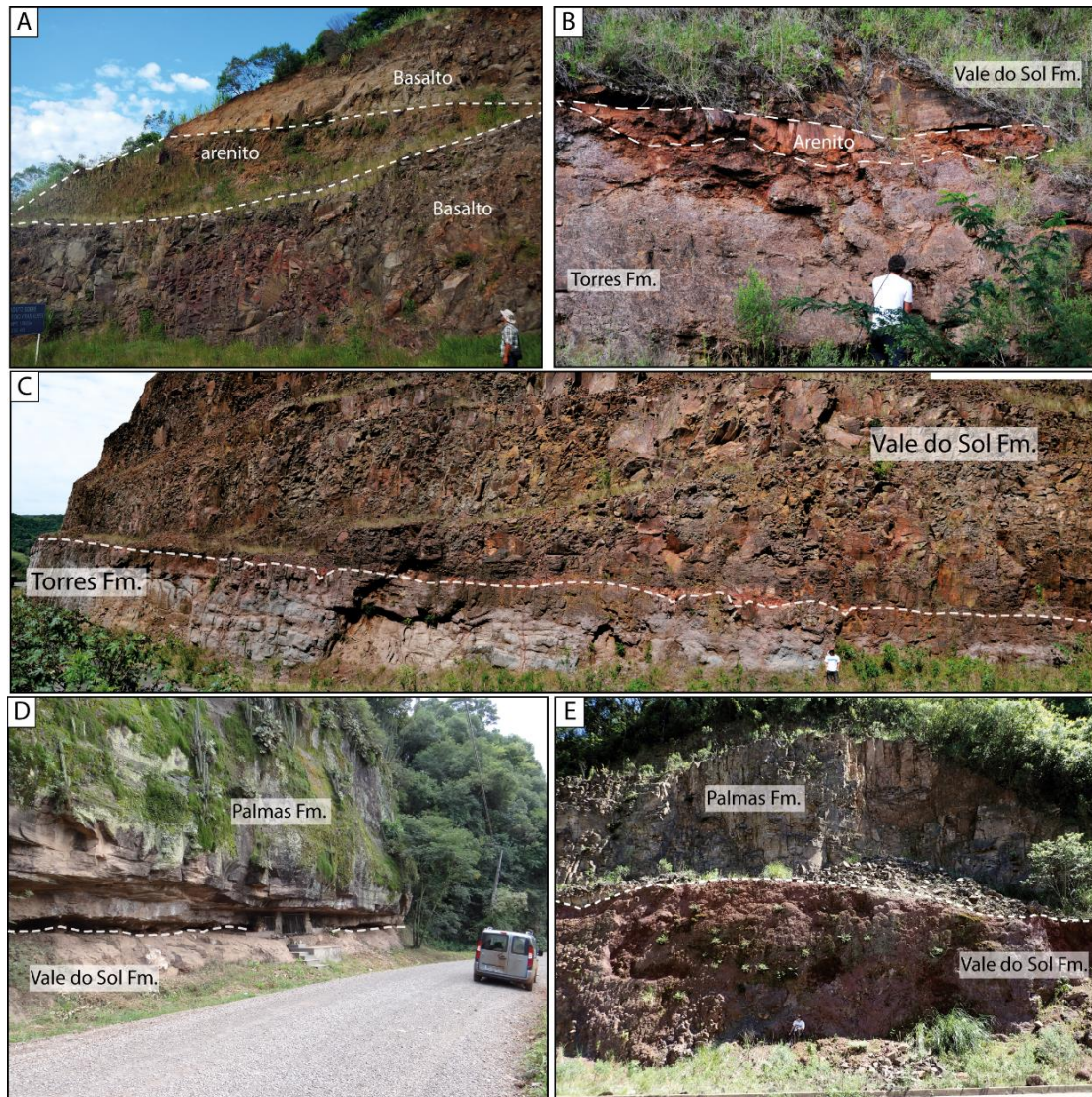
Figura 20 - A) Contato entre dois derrames basálticos, separados por arenito, Formação Torres; B) Contato entre Formação Torres e Formação Vale do Sol na região de candelária, contato marcado por camada de arenito silicificada; C) Contato entre Formação Torres e Formação Vale do Sol na região de Herveiras, camada pouco espessa de arenito entre as unidades; D) Contato entre Formações Vale do Sol e Palmas na região de São Marcos; E) Contato entre as Formações Vale do sol e Palmas na região de Herveiras.
