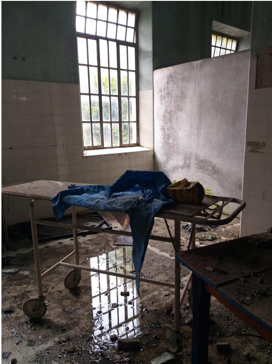
Imagem 23: Intervenção no prédio antigo.
