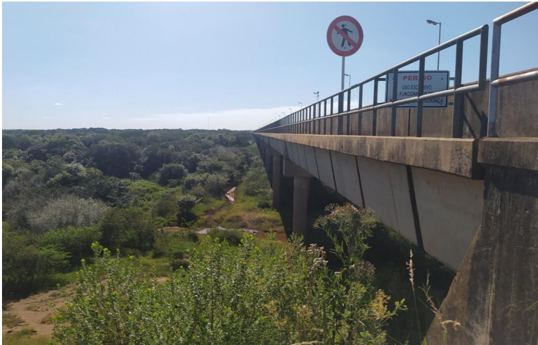
Figura 5 - Ponte Internacional da Integração
