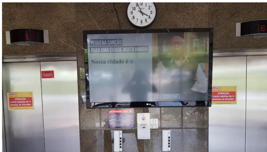
Figura 21: Foto dos Painéis Anunciadores funcionando no saguão do Prédio Administrativo.
