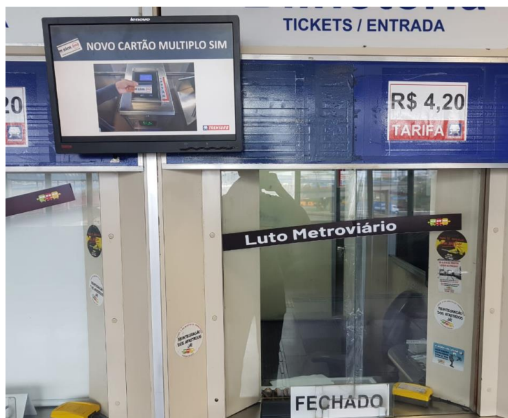
Figura 22: Foto dos Painéis Anunciadores funcionando na bilheteria da Estação Aeroporto.
