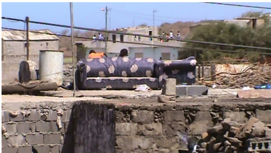
Figura 5 - Vista das áreas de circulação superiores das casas, zona Ribeirão Chiqueiro.
