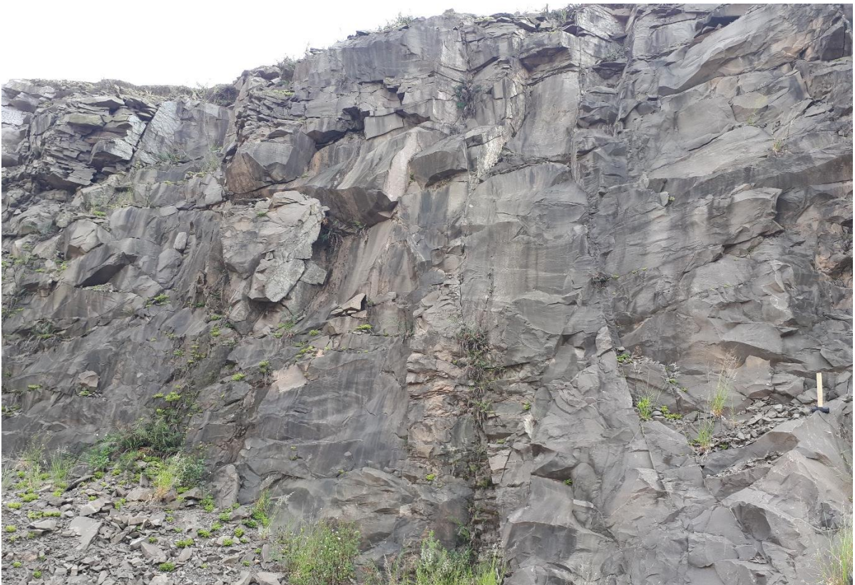
Figura 15. Imagem do setor sem vesículas na orientação NW-SE, evidenciando o fraturamento aleatório e a ausência de vesículas. Marreta: 28 cm.
