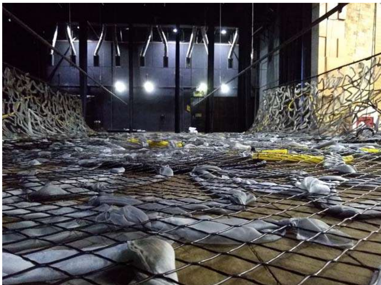
Figura 24: Estrutura cenográfica sendo fixada na primeira e na última vara cênica, por meio de fios de nylon pretos. Fonte: Stefanello Studio.
