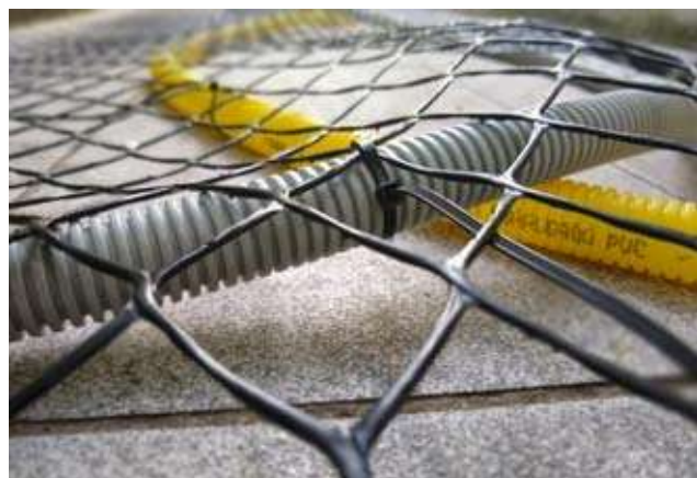
Figura 23: Eletrodutos de 2,5 centímetros de espessura, presos à tela por abraçadeiras de nylon pretas. Fonte: Stefanello Studio.
