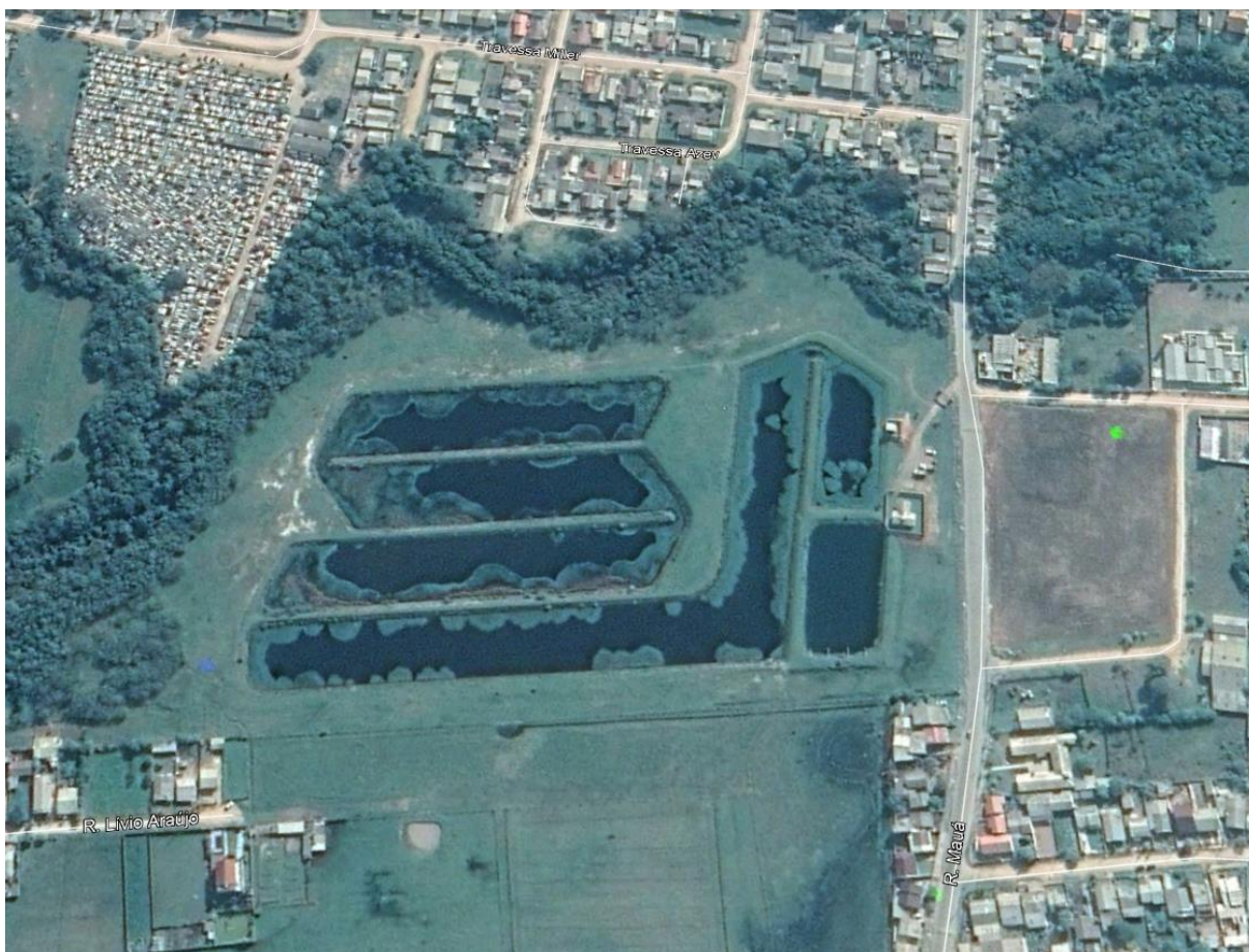
Figura 88. Estação de Tratamento de Esgotos da CORSAN, Tapes/RS.
