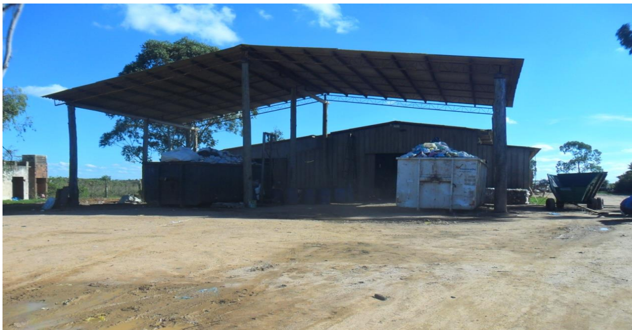
Figura 89. Central de Triagem e Transbordo de Resíduos Sólidos Urbanos, área frontal. FONTE: Autora, 2021.
