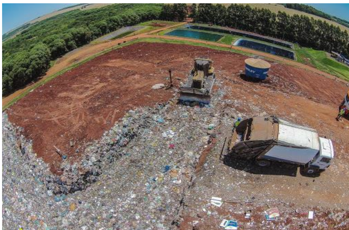
Figura 95. Aterro Sanitário CRVR –Minas do Leão/RS. FONTE: CRVR, 2021.
