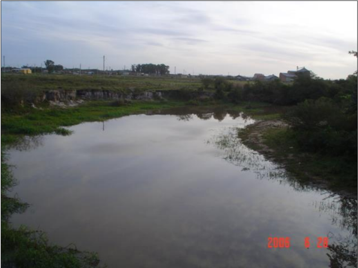
Figura 68. Margem da Sub-bacia do Arroio Teixeira desprovida de vegetação e com processos erosivos em 2006.
