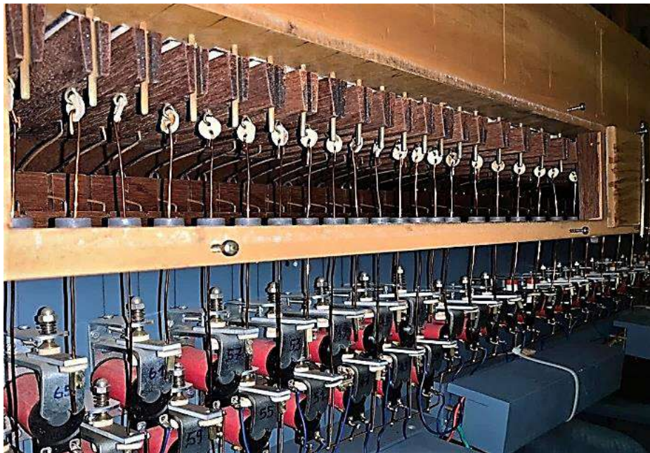
Figura 28 – Eletroímãs que movimentam as válvulas do someiro.
