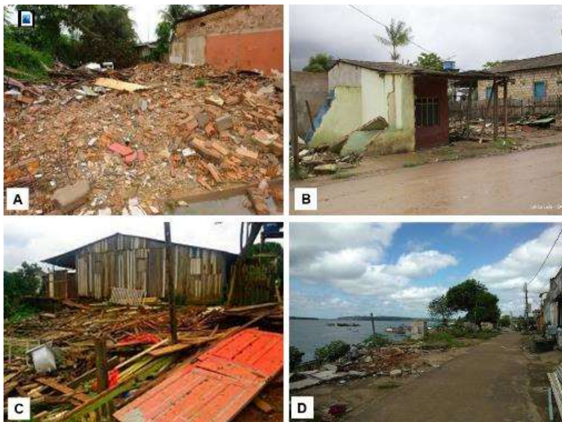
Figura 29. Resto de demolição das casas A: Casa demolida no Açaisal; B: Casa Demolida na Invasão dos Padres; C: Casa demolida no Aparecida; D: Casa Demolida na Orla de Altamira Fonte: Acervo Pessoal, 2014; ISA, 2015.
