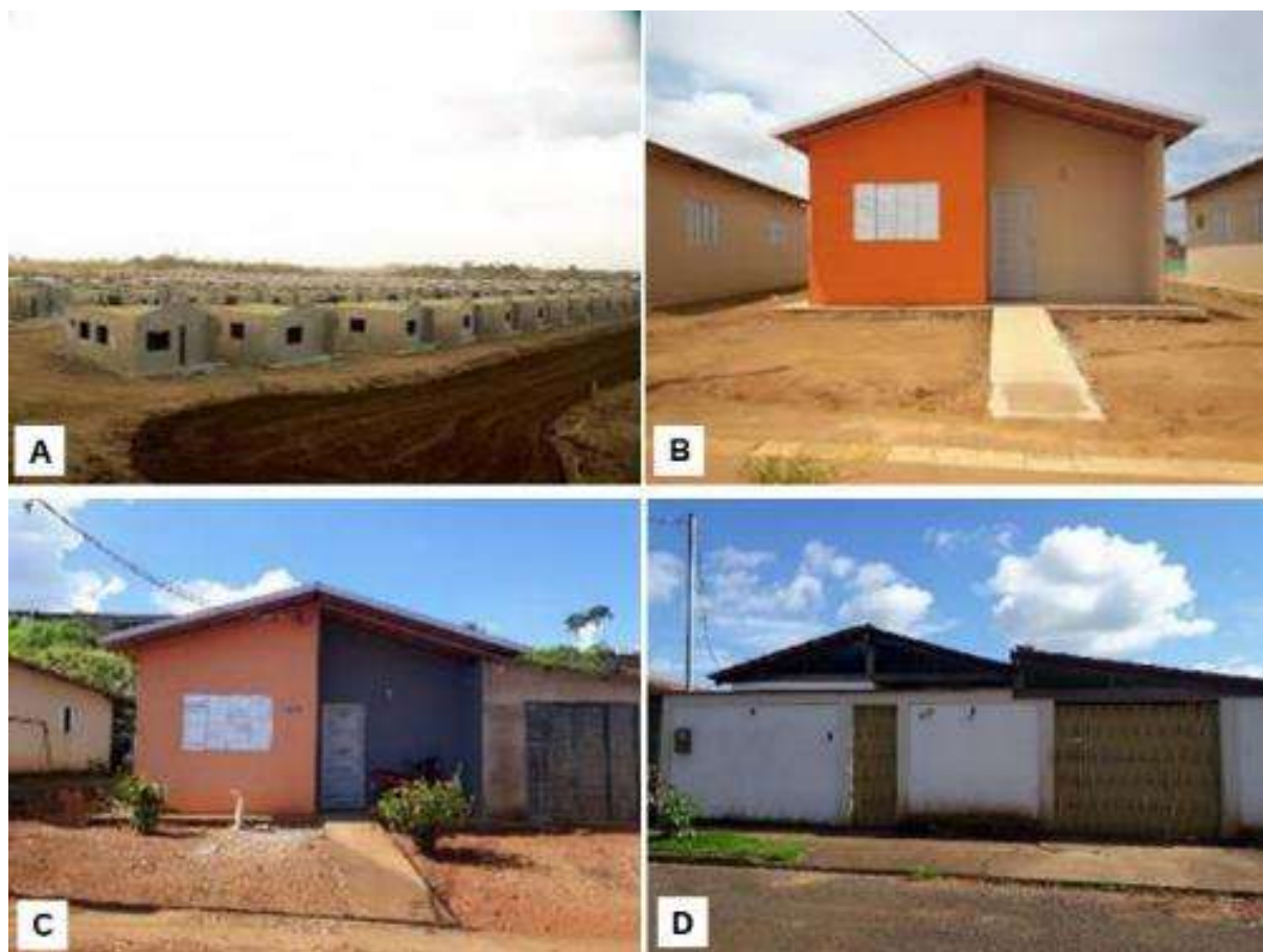
Figura 37. Início de Construções das Casa e Casas Prontas A: Casas em Construção; B: Casa Padrão; C: Casa Padrão com Construção ao lado; D: Casa Padrão Murada e Modificada Fonte: Norte Energia e Acervo Pessoal
