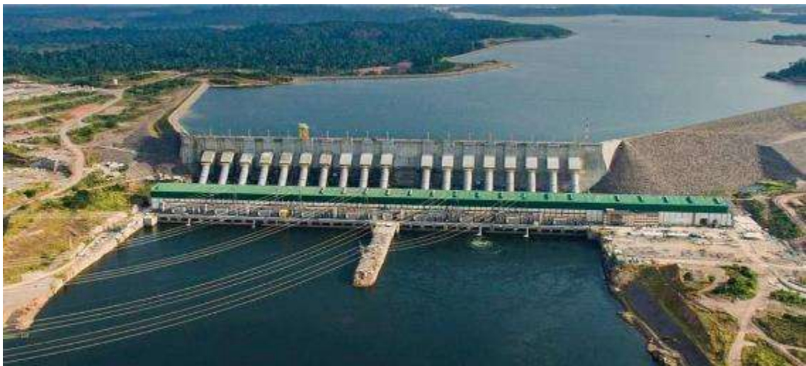
Figura 2. Vista da Casa de Força Principal da UHE Belo Monte Fonte: Xingu230, 2020.
