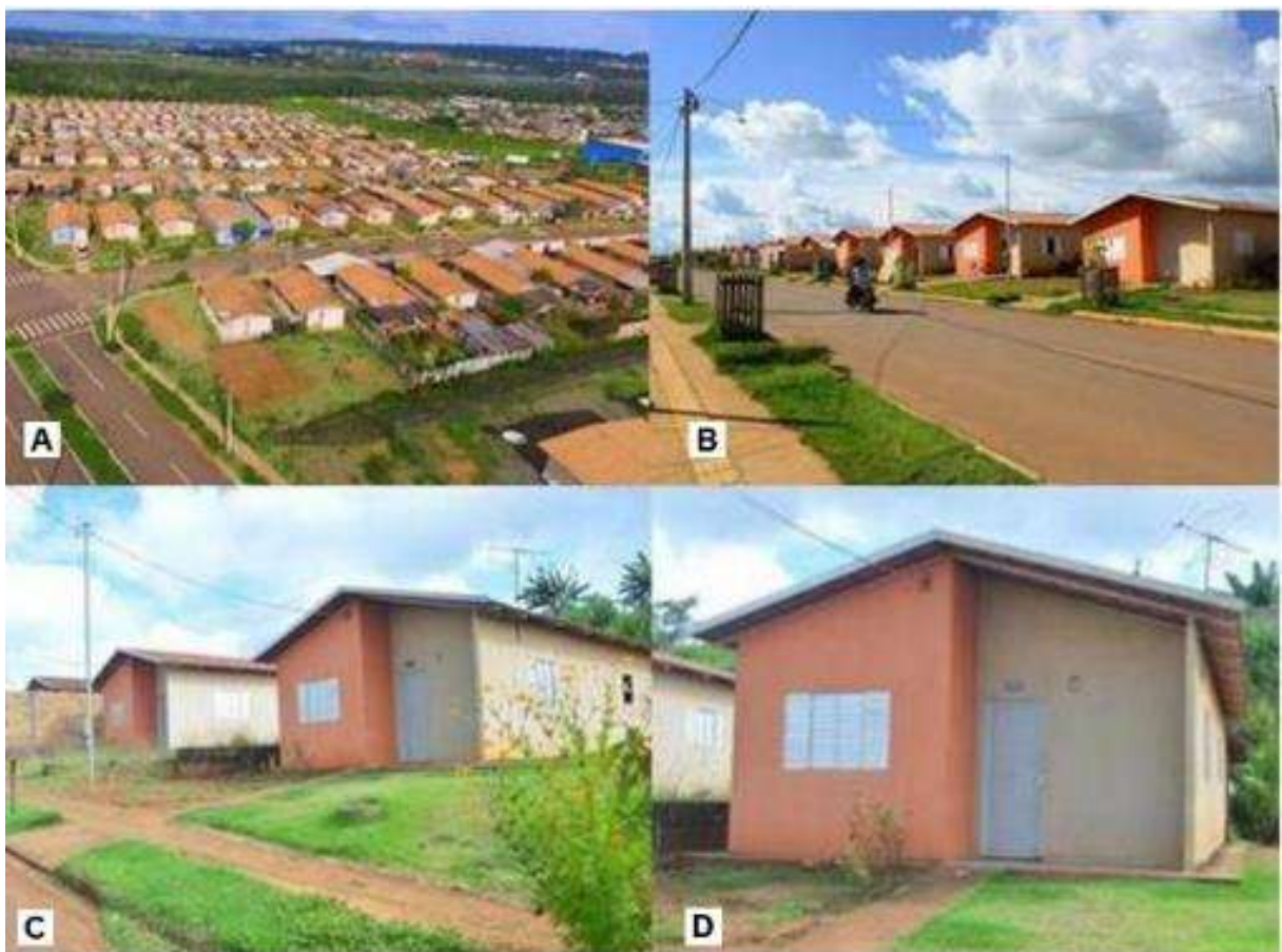
Figura 11. Reassentamento Urbano Coletivo A: Vista aérea B: Rua do RUC; C: Casa do RUC; D: Casa do RUC Fonte: Acervo Pessoal, 2018.
