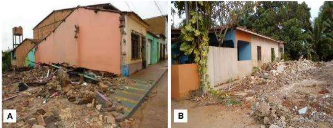
Figura 27. Casa Demolida após Remanejamento da Família Fonte: Norte Energia; CIMI.
