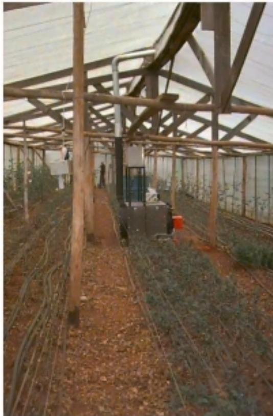
Figura 3.3 – Vista da plataforma contendo aquecedores, tanque de expansão e bomba
