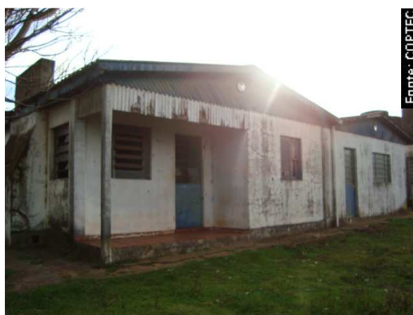
Figura 10 – Casas existentes ao lado no Centro Comunitário do PA Nossa Senhora da Conceição.
