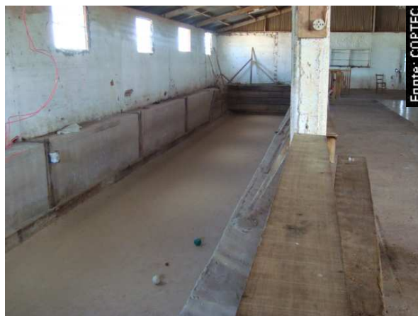
Figura 08 – Cancha de bocha do PA Nossa Senhora da Conceição
