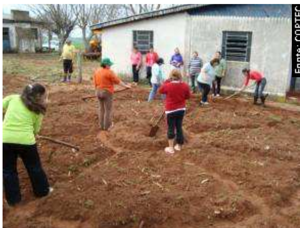
Figura 11 – Construção da horta de plantas medicinais pelo grupo de mulheres do PA Nossa Senhora da Conceição.
