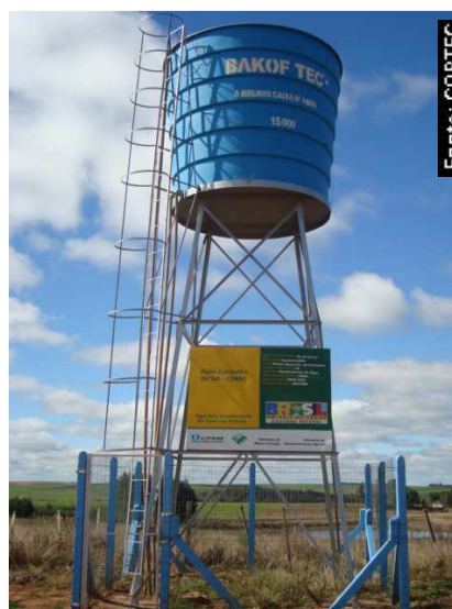
Figura 06 – Poço artesiano do PA Nossa Senhora da Conceição
