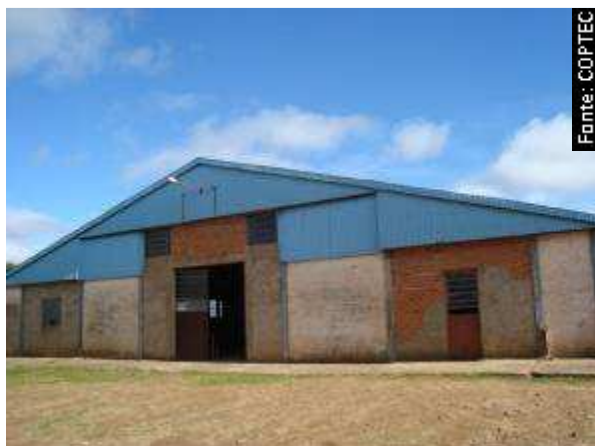
Figura 07 – Centro Comunitário do PA Nossa Senhora da Conceição.
