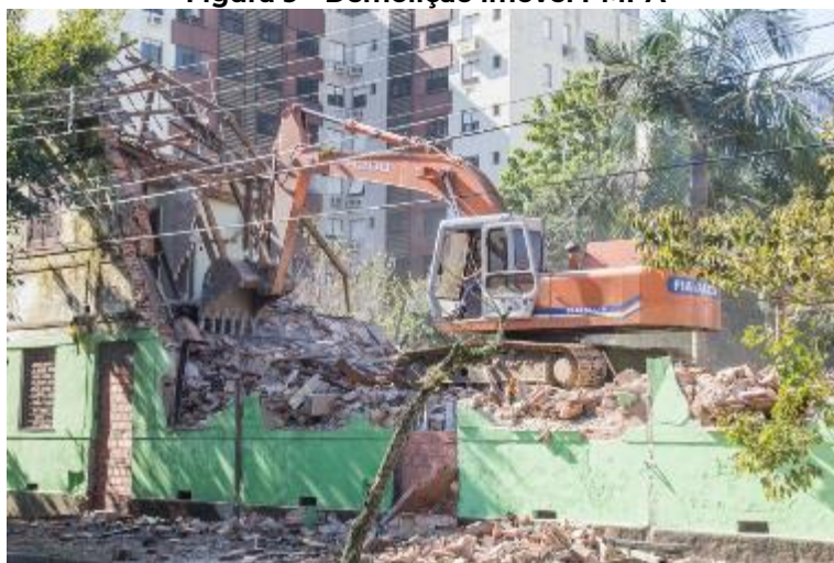
Figura 9 - Demolição imóvel PMPA
