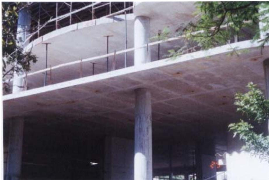
FIGURA 1.1 - Estrutura com laje cogumelo em construção.
