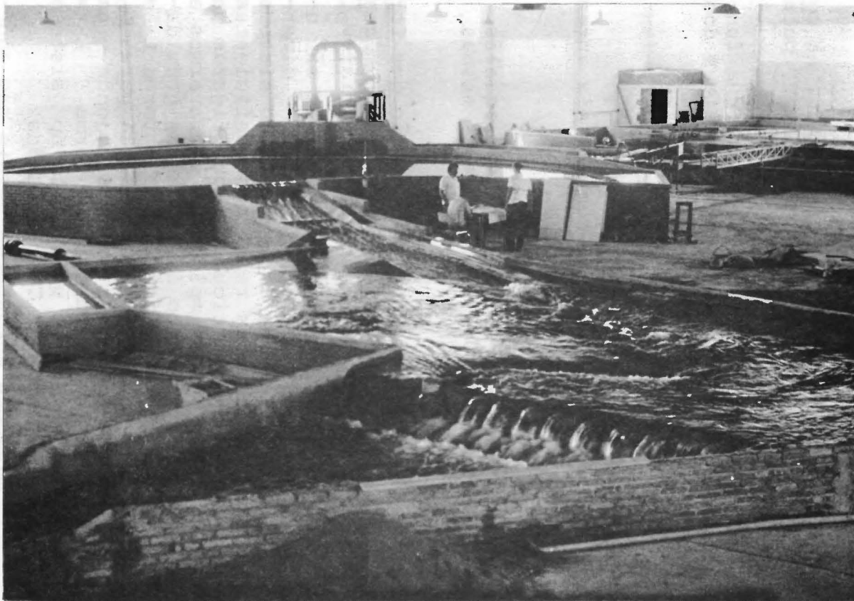
3 - Vista geral do modelo reduzido (1/70) do sangrador da barragem de Passo Real, RS (IPH da UFRGS)
