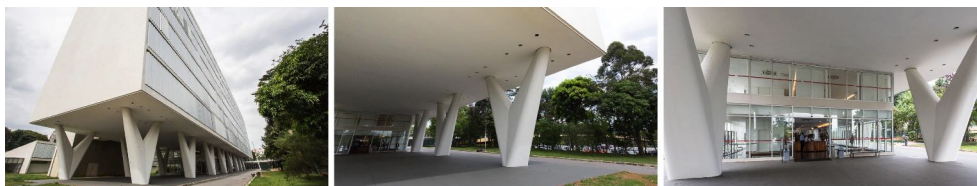
Figura 50: MAC-USP, três pontos de vista do pilotis no nível térreo.
