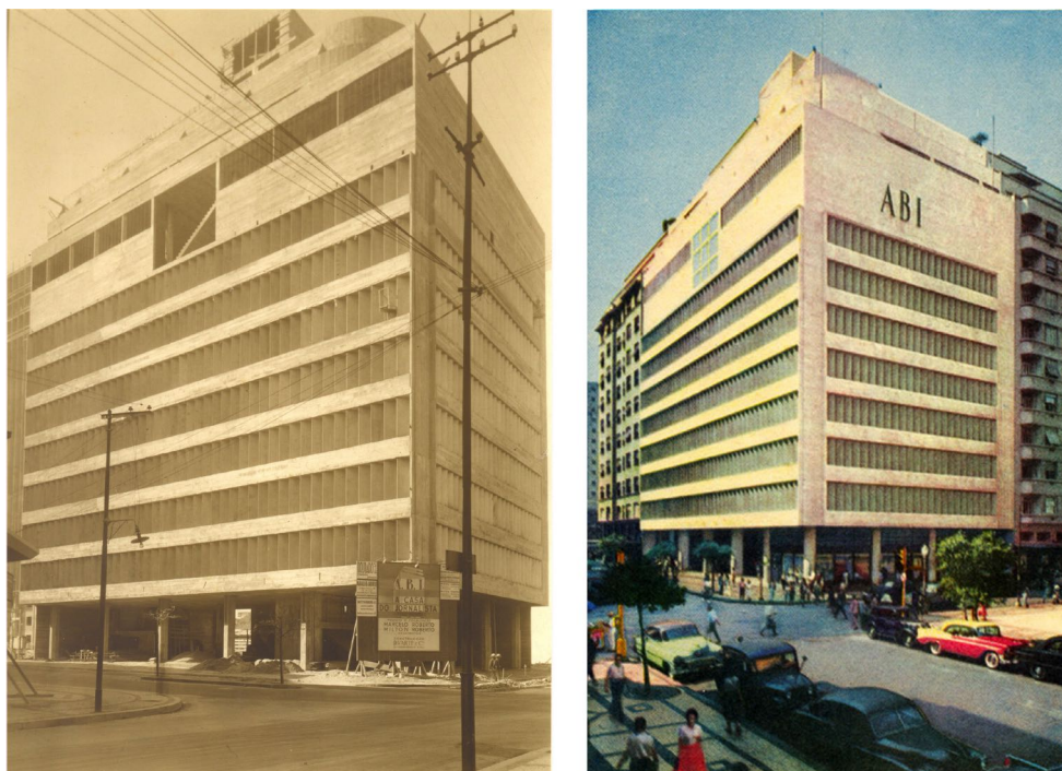
Figura 20: Edifício sede da ABI em obras (esq.) com os pilares do pilotis ainda com seção retangular; e o edifício já construído na década de 1940. Fonte: Acervo do Núcleo de Pesquisa e Documentação – FAU/UFRJ – Brasil. / Acervo ABI.
