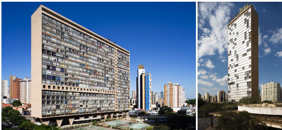
Figura 62: Torre do Bloco A sobre pilotis de pilares W (à esquerda). À direita, a torre de apartamentos do Bloco B, com sua fachada de brises de alumínio.
