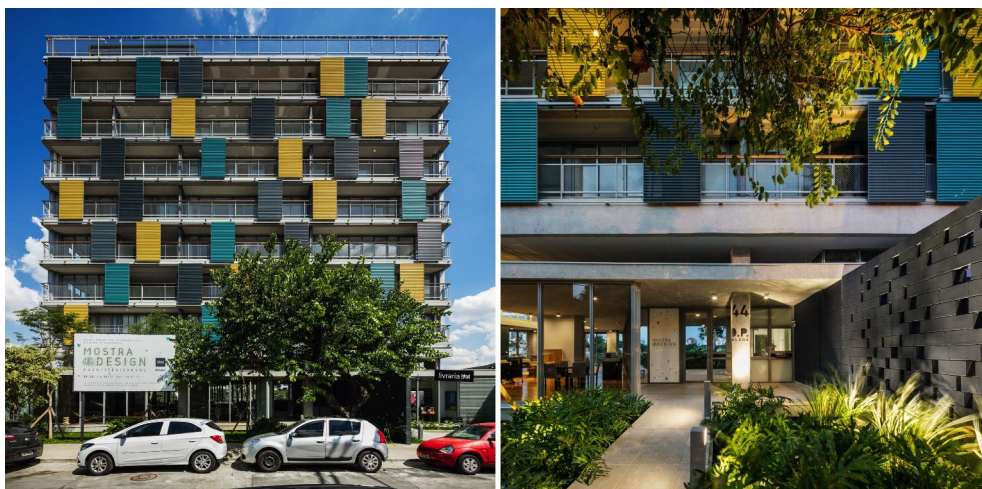
Figura 108: Fachada da Rua Madalena (à esquerda), e vista da área de acesso ao edifício residencial pelo vazio entre as duas lojas.
