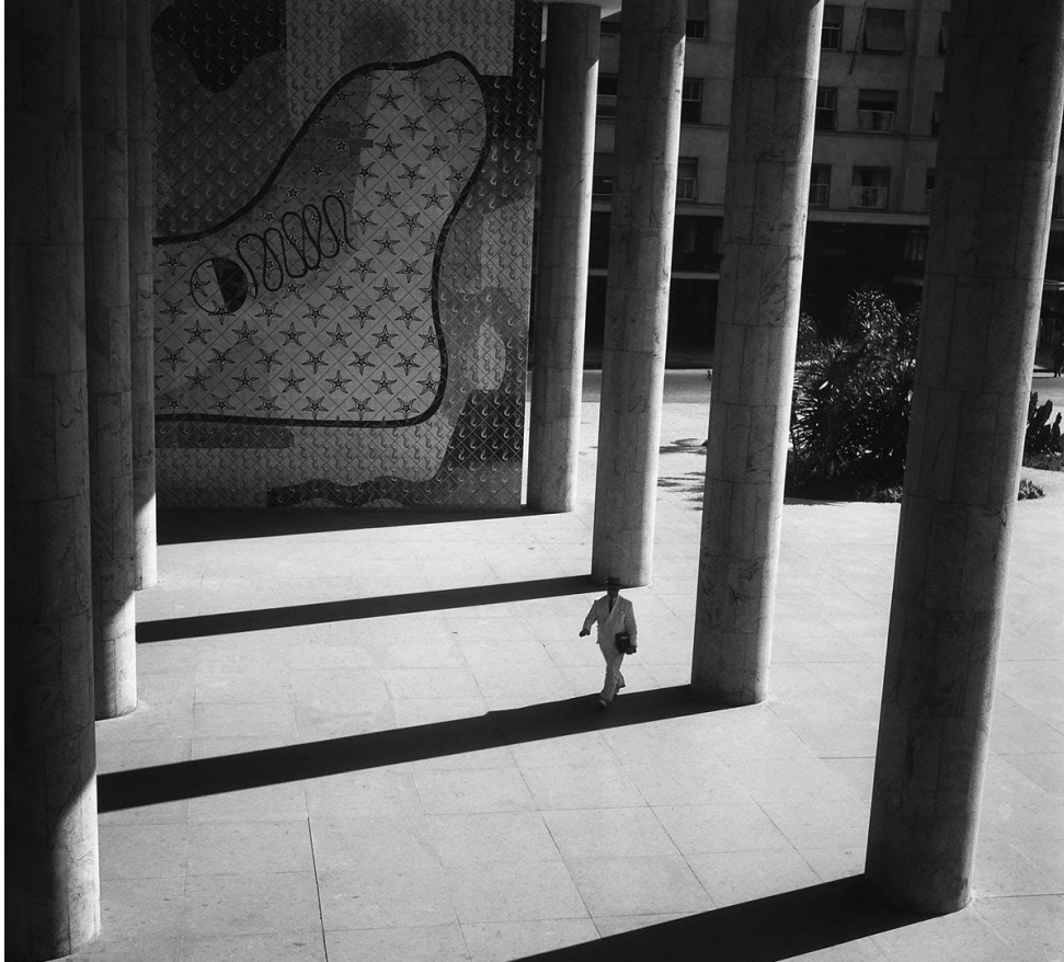
Figura 15: Pilotis do Ministério de Educação e Saúde no Rio de Janeiro, 1936-1945. Fonte: Foto Marcel Gautherot, acervo IMS.
