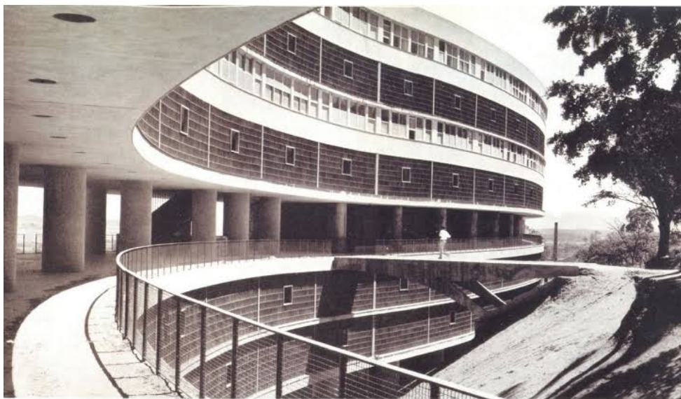
Figura 65: Vista do pilotis intermediário do Pedregulho. Fonte: BONDUKI, 2000, p. 91.
