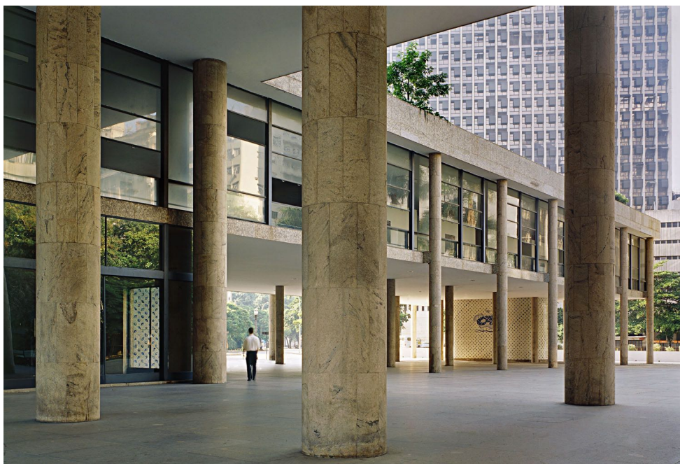
Figura 28: Os pilotis do MES, sob a lâmina de escritórios e sob a barra que abriga a sala de exposições. Fonte: Foto Nelson Kon.
