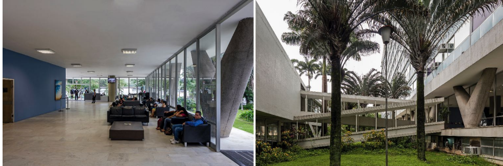
Figura 54: Hospital da Lagoa, pilares em V vistos desde o hall (à esquerda), e conexão entre o volume anexo frontal e a base do bloco hospitalar sobre pilotis. Fonte: Fotos Leonardo Finotti.
