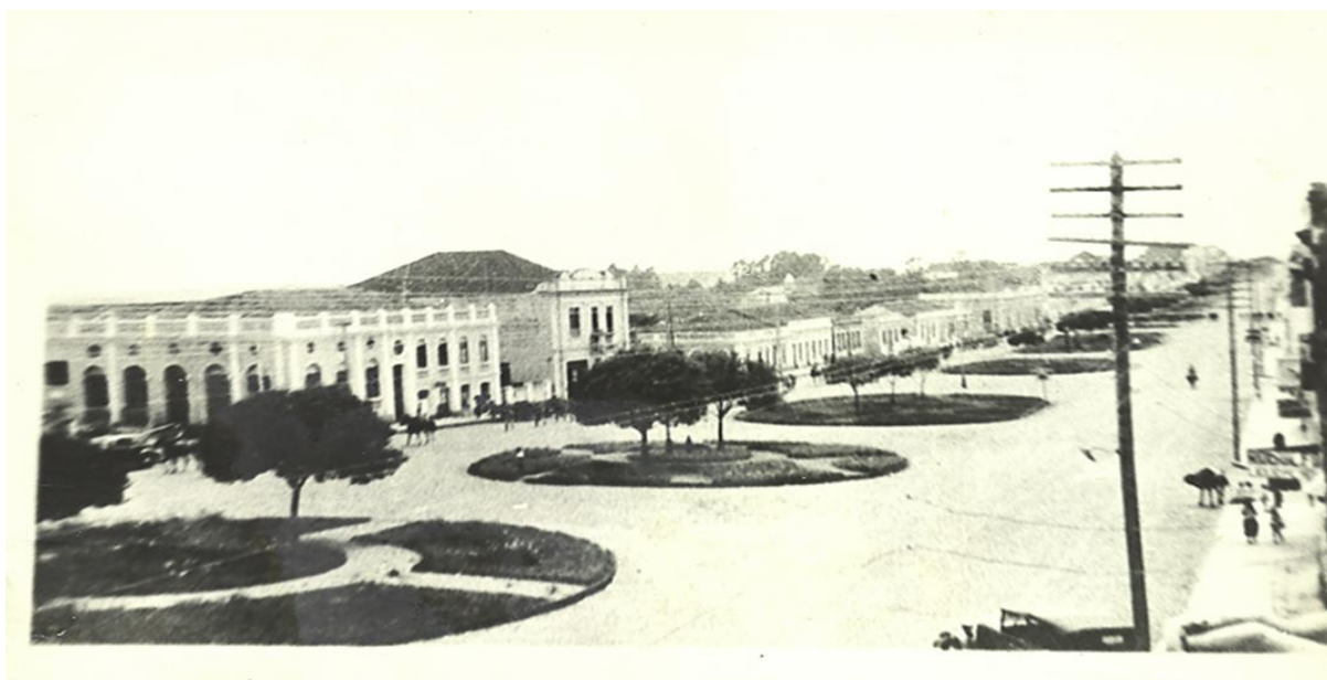
Figura 33- Vista da Avenida Brasil, na década de 1930 e Casa Gabriel Bastos
