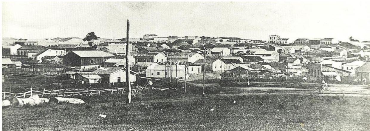
Figura 31 - Vista da área central da cidade por volta de 1914
