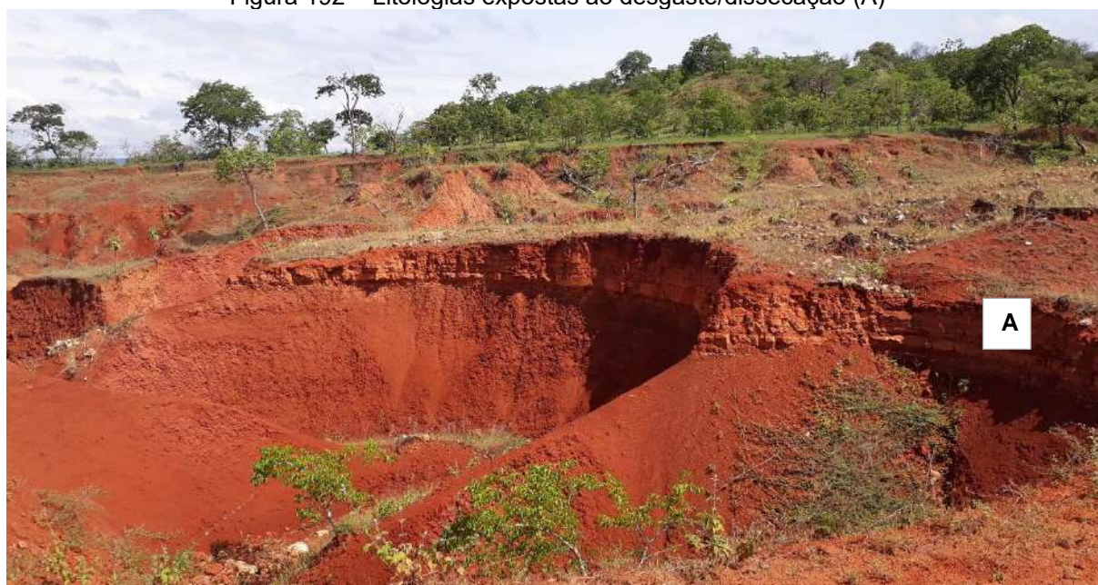
Figura 192 – Litologias expostas ao desgaste/dissecação (A)
