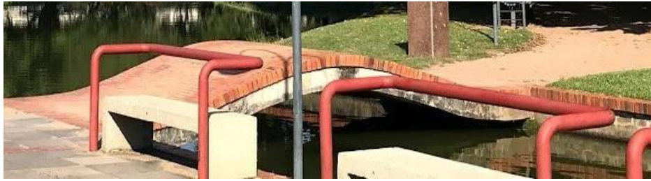
Figura 4: Ponte inspirada na Ponte del Diavolo de Veneza
