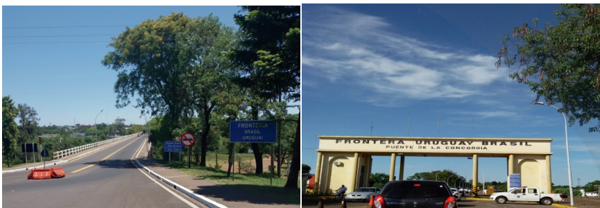
Figuras 4A e 4B – Imagens da Ponte da Concórdia, entre Quaraí (à esquerda) e Artigas
