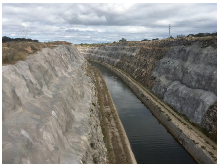
Figura 10 – Imagem do trecho da transposição do rio São Francisco, em Monteiro (PB)
