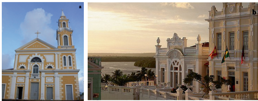
Figura 5 – Edificações no Largo de São Frei Pedro Gonçalves. a) Visão frontal da Igreja São Frei Pedro Gonçalves. Foto: Luciano S. Pereira (abril/2016); b) Visão lateral do Hotel Globo e do prédio anexo, com o Rio Sanhauá ao fundo. Foto: Gilberto Stuckert.
