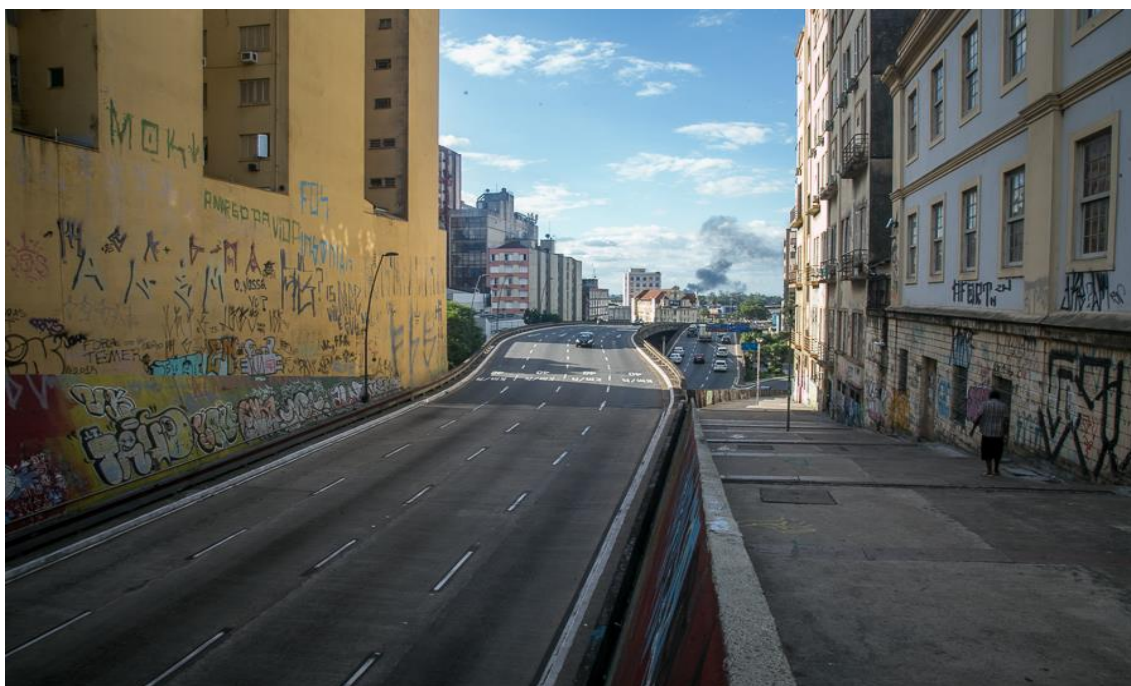
Figura 1 – Viaduto da Conceição, Porto Alegre – RS.
